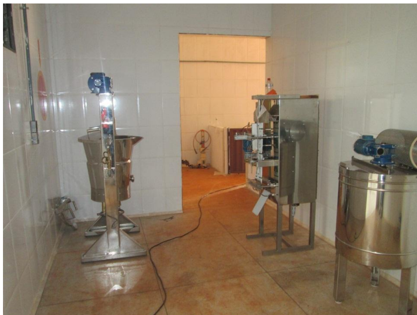
Área de despulpamento
