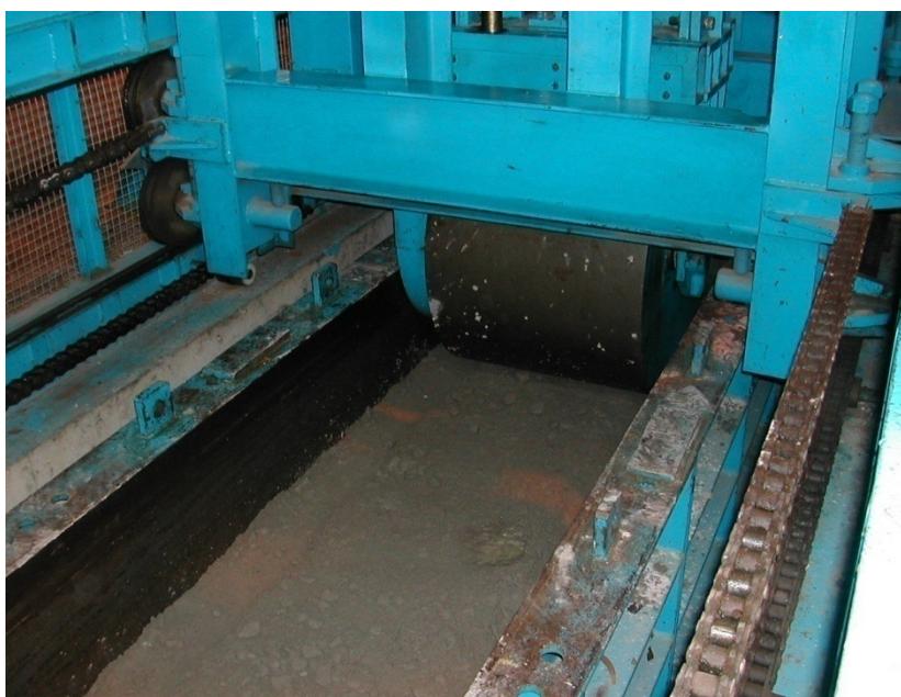
Figura 1. 1 – Rolo compactador do laboratório de concreto de FURNAS em Aparecida de Goiânia – GO
