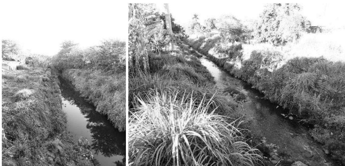
Figura 151 – Fotografias referentes aos indícios do ponto 15 do mapa de indícios (Figura 134), localizados sob a ponte da Avenida Marechal Rondon.
