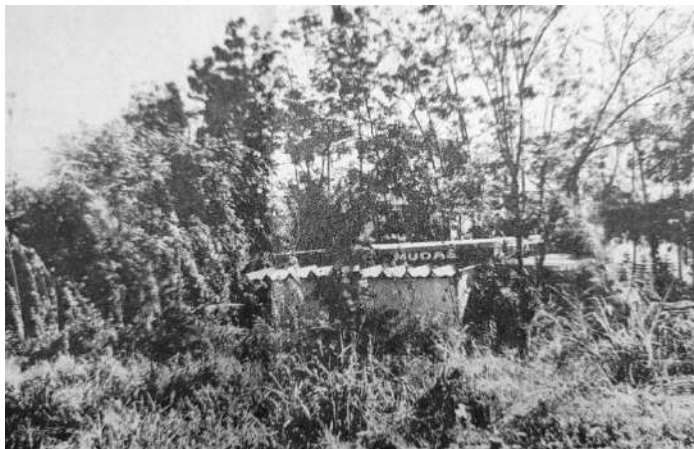
Figura 54 – Viveiro do “Seu Valdemar” localizado no interior do Bosque dos Buritis e demolido para a construção do edifício Alfredo Nasser, em aproximadamente 1958.
