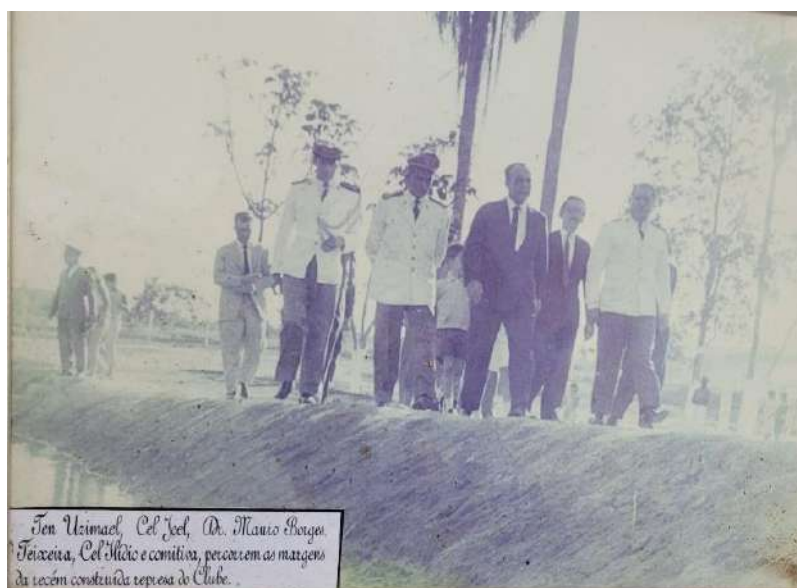
Figura 68 – Fotografia tirada no Clube dos Oficiais, provavelmente em meados da década de 1970.
