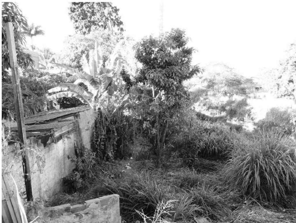
Figura 217 – Ocupações irregulares e vegetação às margens do córrego Capim Puba, no local de desague da segunda foz córrego dos Buritis.
