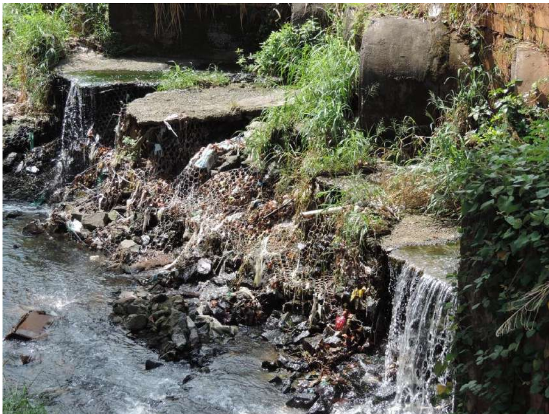
Figura 127 – Tubulação de desague do córrego dos Buritis no córrego Capim Puba.
