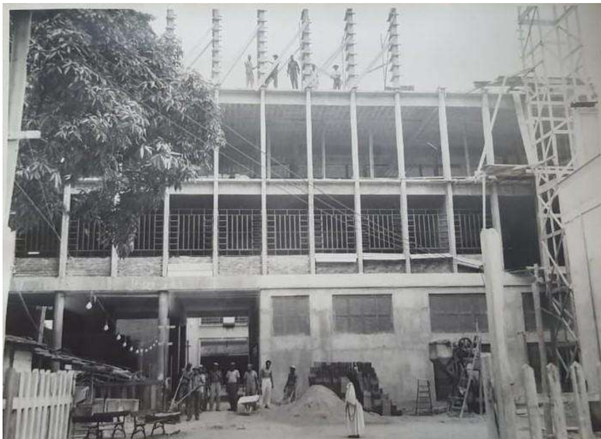
Figura 49 – Construção da atual sede do Colégio do Externato São José, início da década de 1960.
