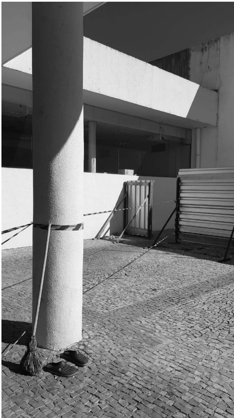
Figura 266 – Palácio Alfredo Nasser em reforma e todo cercado com tapume metálico devido à saída da Assembleia Legislativa e à nova ocupação pelo Tribunal de Contas do Município de Goiânia.
