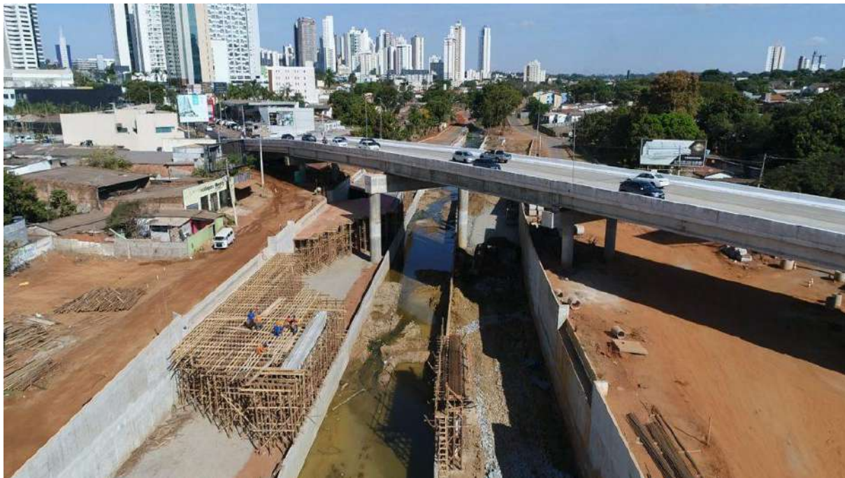
Figura 13 – Obras na Marginal Botafogo em Goiânia, onde se encontra canalizado, desde a década de 1990, o córrego Botafogo.
