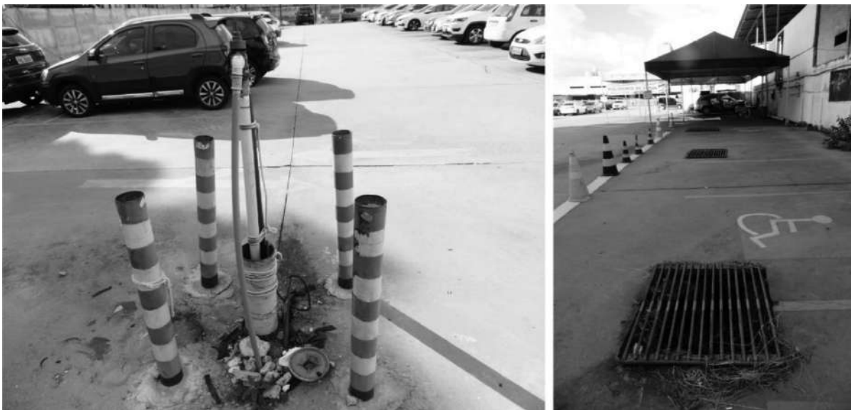
Legenda: Nas imagens vê-se elementos de drenagem e uma estrutura que se parece com algum tipo de poço ou cisterna, localizados no estacionamento do Jockey Clube de Goiás. Fonte: Acervo fotográfico da autora (2019).
