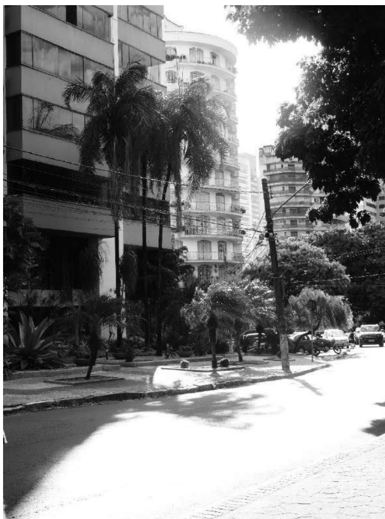
Figura 166 – Edifícios na Rua 01.
