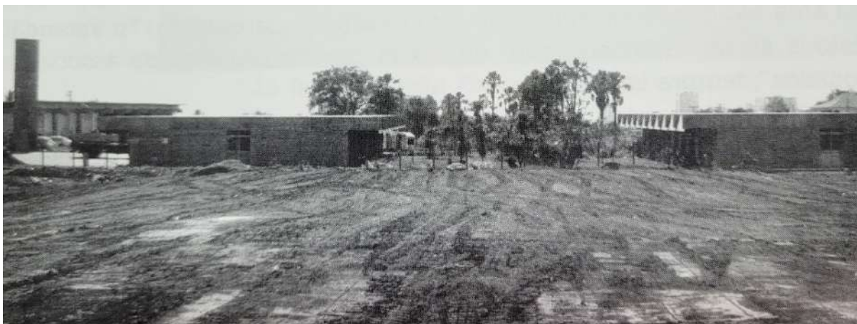
Figura 73 – Local do campo de futebol do Clube de Engenharia já drenado, no momento de sua construção.
