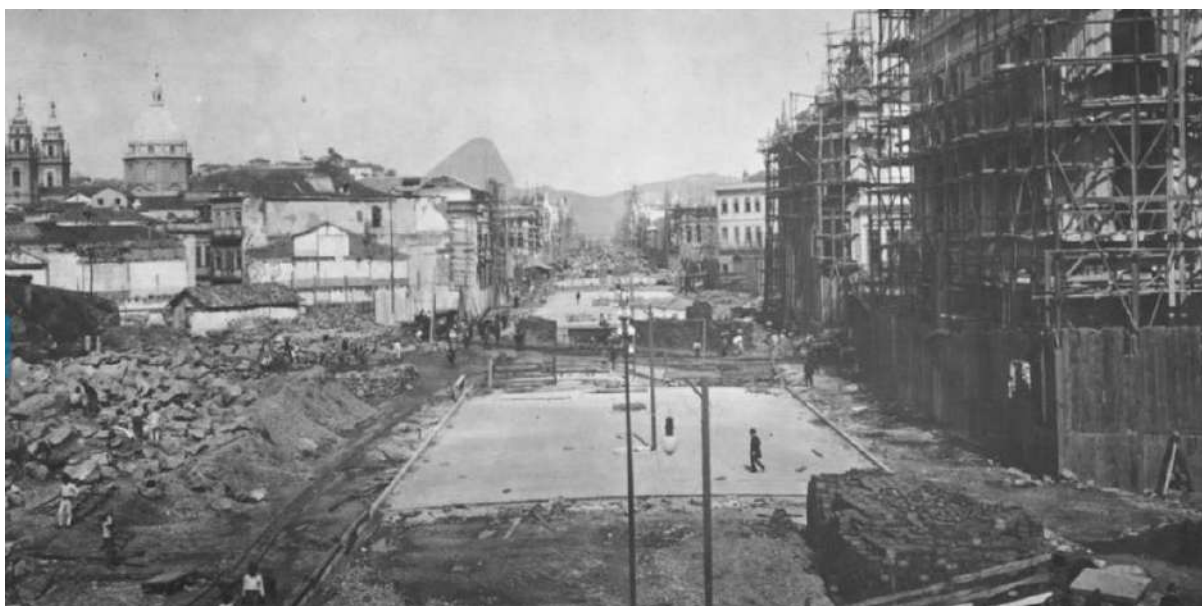
Figura 8 – Fotografia da abertura da Avenida Central, Rio de Janeiro, 1904.
