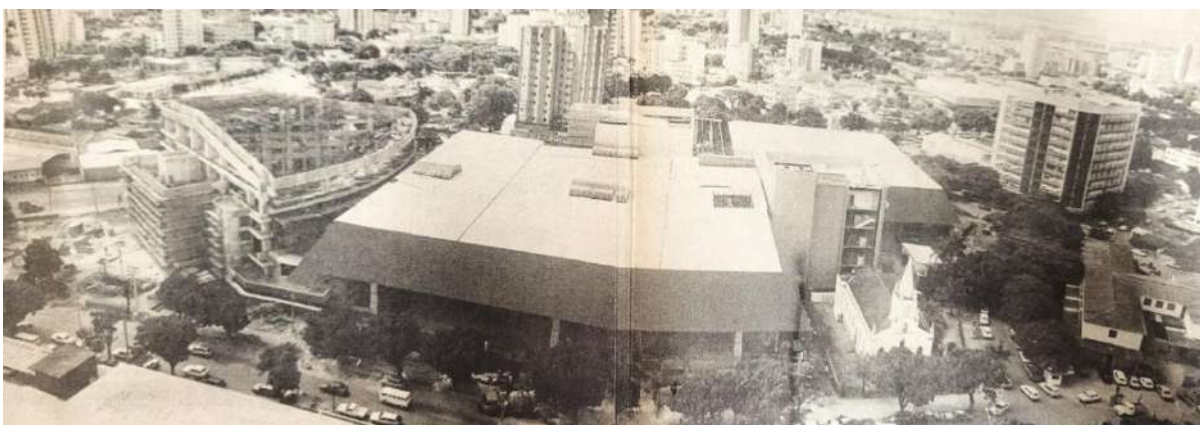
Figura 116 – Centro de Convenções de Goiânia em construção.
