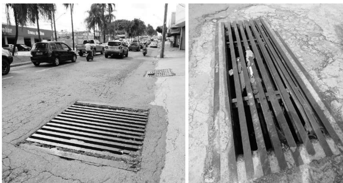
Figura 124 – Bueiros localizados nas avenidas Independência e Oeste no período da seca.
