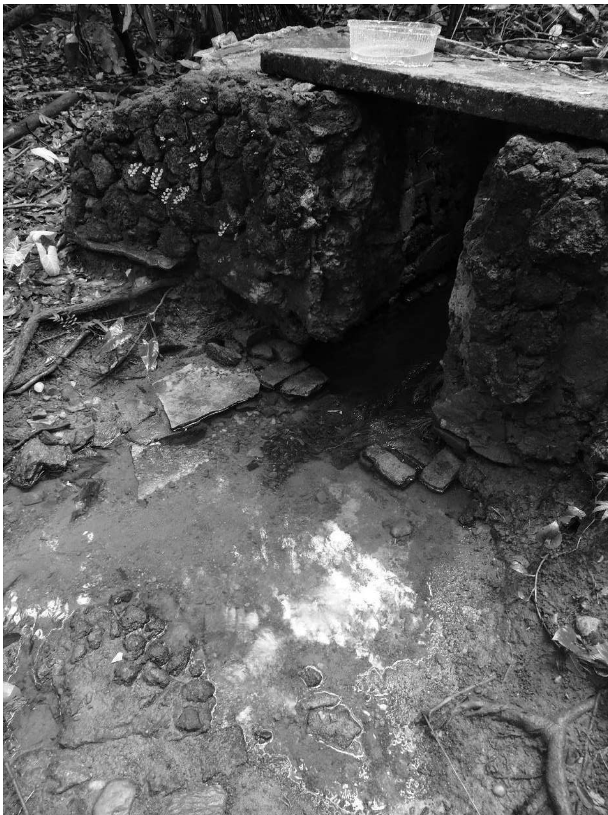
Figura 304 – Nascente existente no interior da mata do Bosque dos Buritis.
