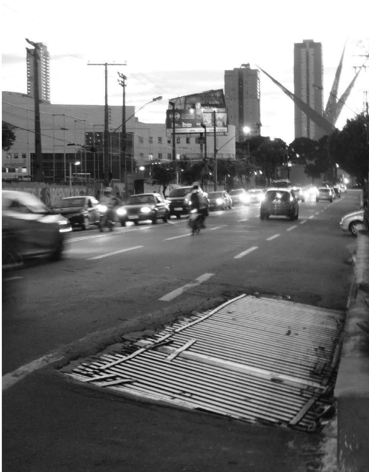
Figura 207 – Grades sobre caixa de passagem que abriga a canalização do córrego dos Buritis na Rua 87, em frente ao Instituto Goiano de Oncologia e Hematologia - INGOH.
