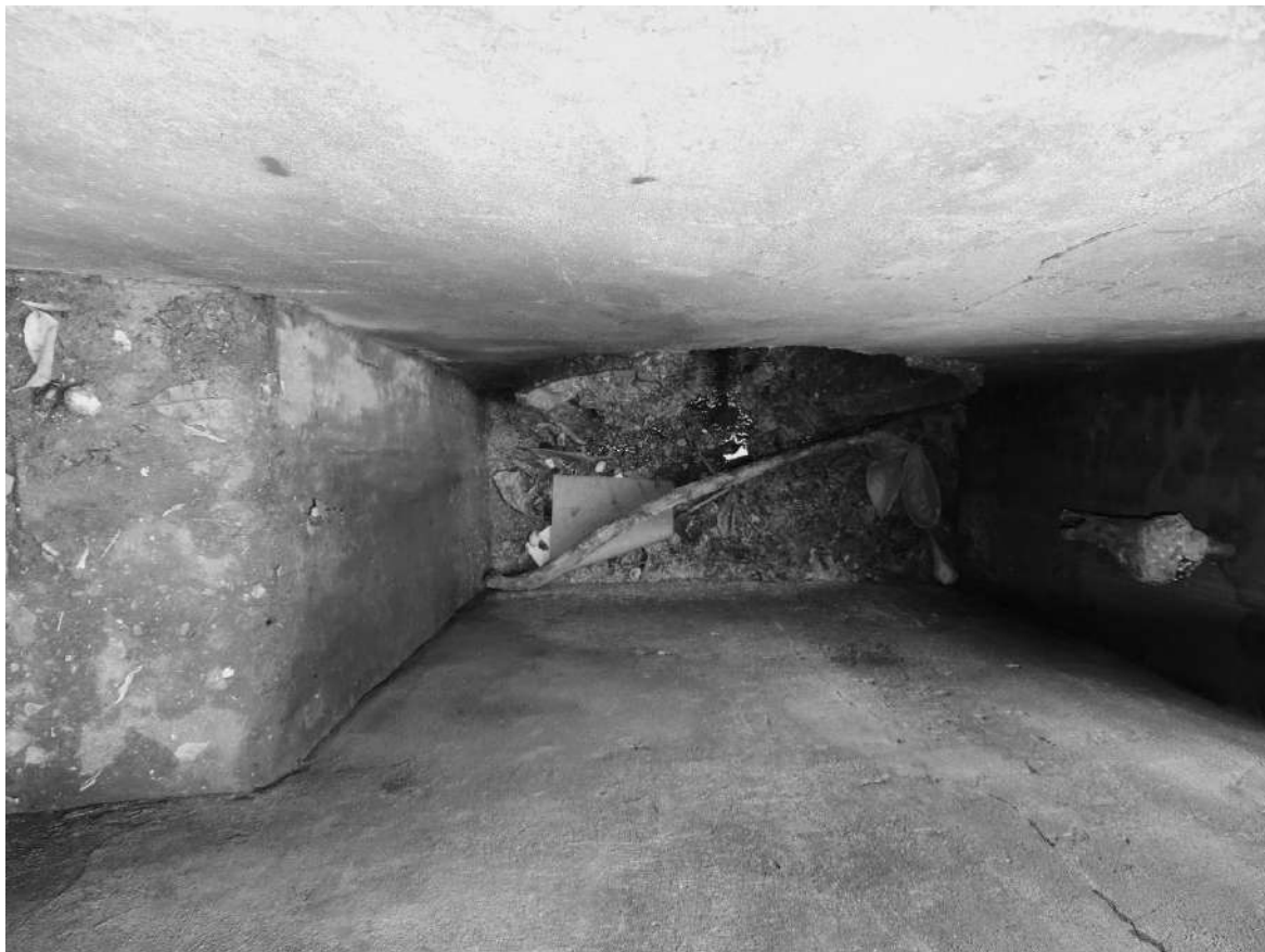
Figura 248 – Caixa de passagem localizada na Rua 15-A sem a presença de água, pois a foto foi tirada no período de seca.
