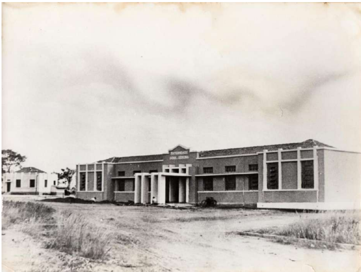
Figura 29 – Maternidade Dona Gercina, implantada em 1943, dentro da estrutura da Santa Casa de Misericórdia de Goiânia, instituição que foi inaugurada em 1937.
