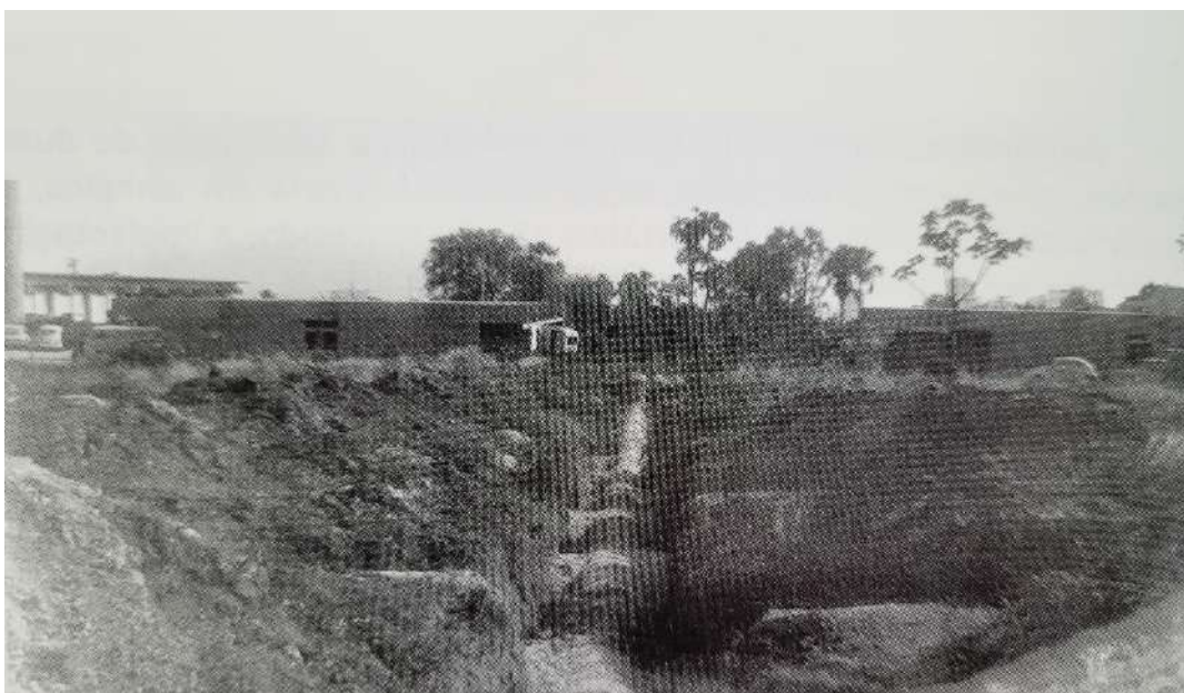
Figura 72 – Canalização feita para o córrego dos Buritis cujo objetivo era a drenagem e construção do campo de futebol do Clube de Engenharia.
