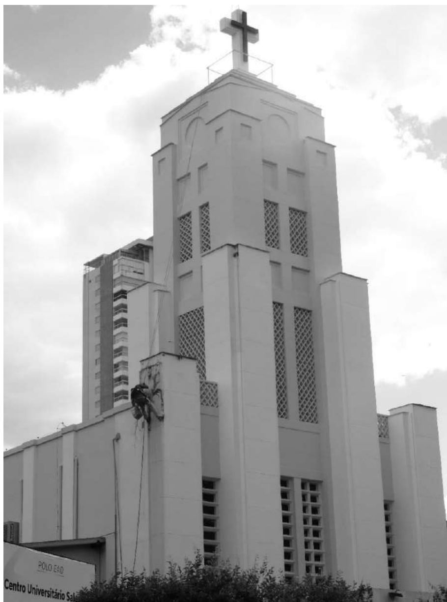
Figura 192 – Homem fazendo algum tipo de reparo ou manutenção na torre da igreja da Paróquia São João Bosco.
