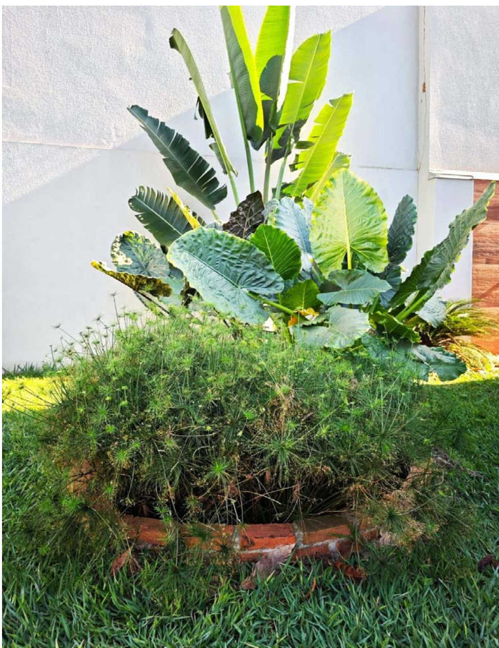
Fotografia 1. Imagem registrada em junho de 2025 da wetland construída (reservatório circular com bordas em tijolo aparente), vegetada com papiro-anão.
