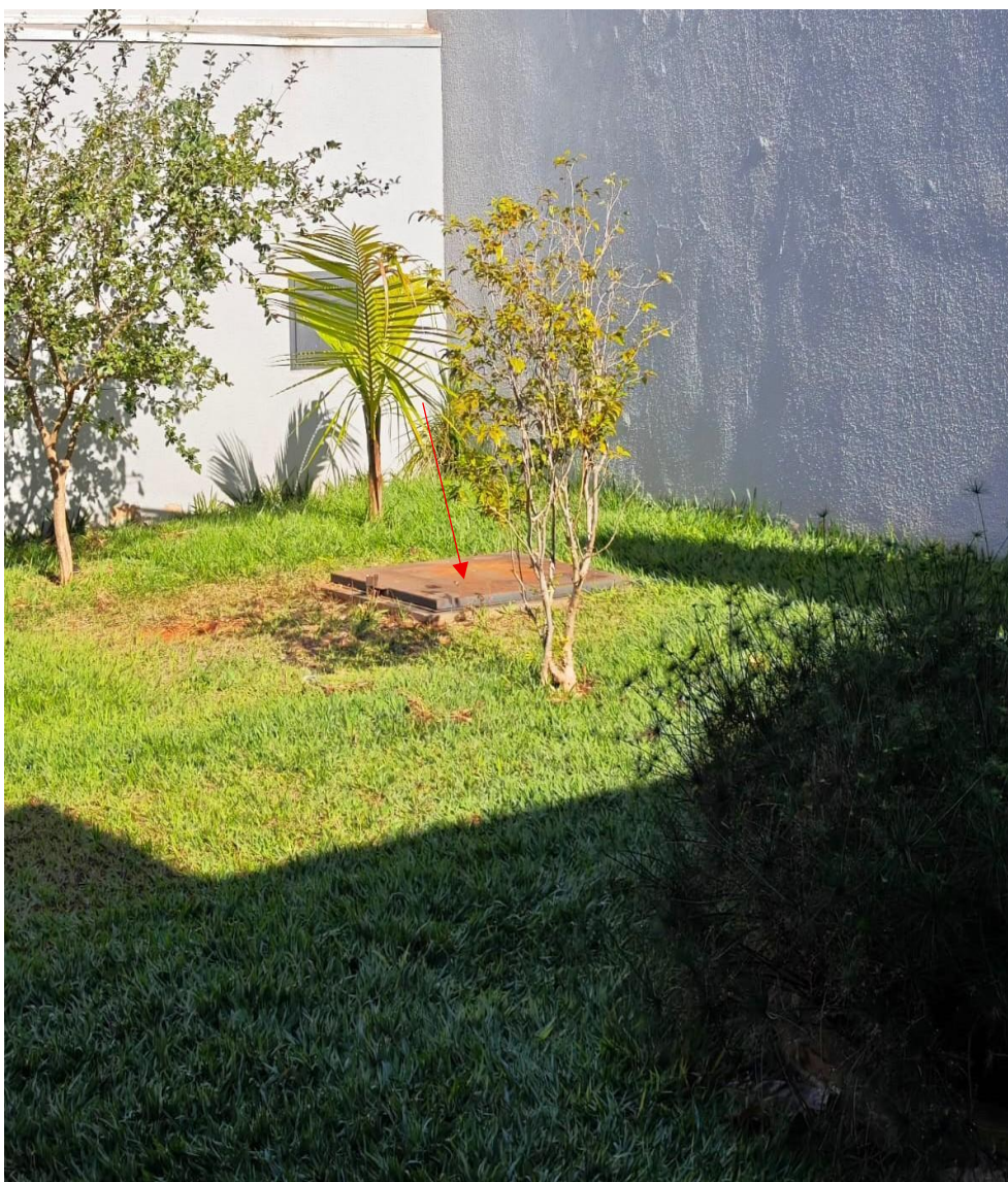
Fotografia 2. Imagem registrada em junho de 2025 do reservatório subterrâneo destinado ao armazenamento e à aeração de águas pluviais e cinzas.
