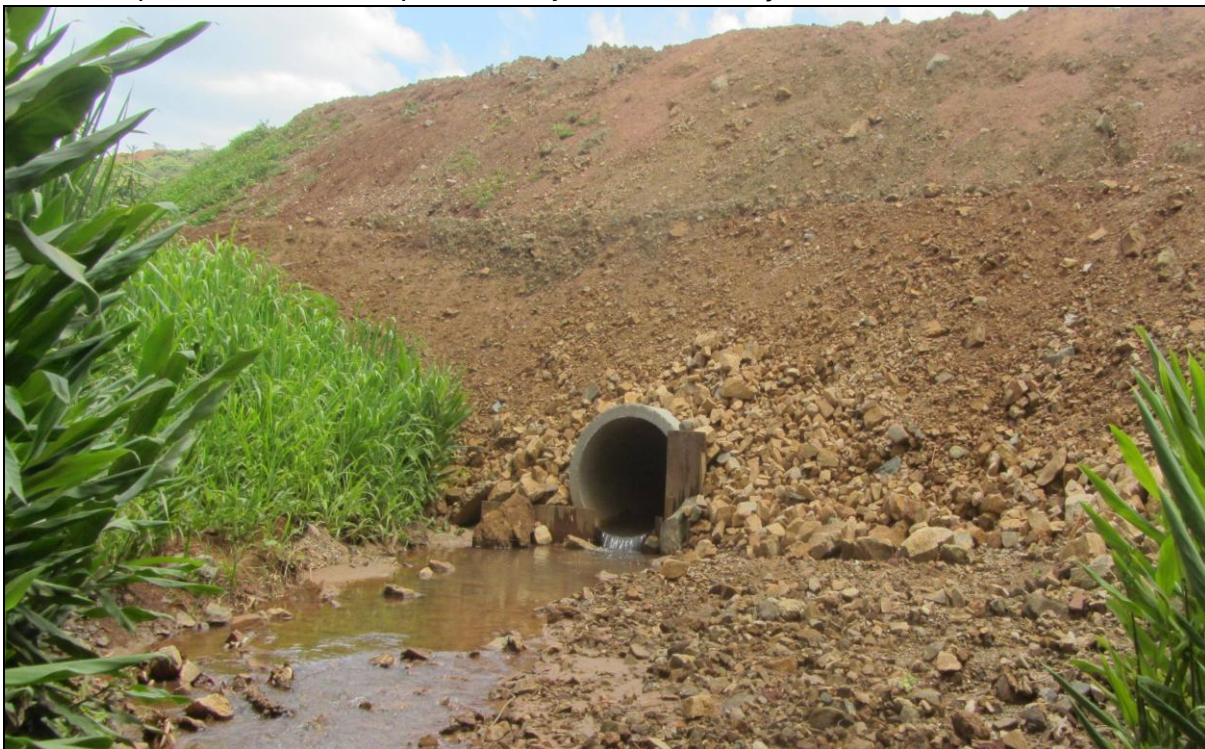
Foto 14 – Registro fotográfico do mesmo local da foto 13 após a conclusão das obras da estrada que dá acesso ao depósito de rejeitos da mineração na Mina Boa Vista.
