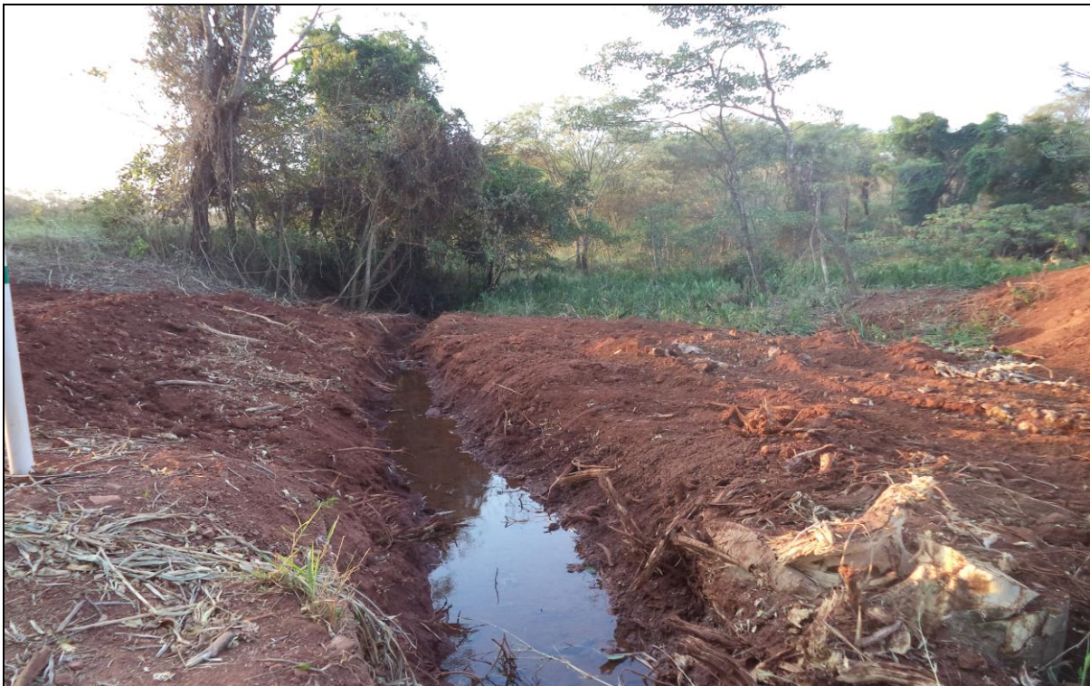
Foto 13 - Intervenção ambiental no leito do Córrego Tombador Comunidade Coqueiros, para construção de estrada que dá acesso ao depósito de estéril.
