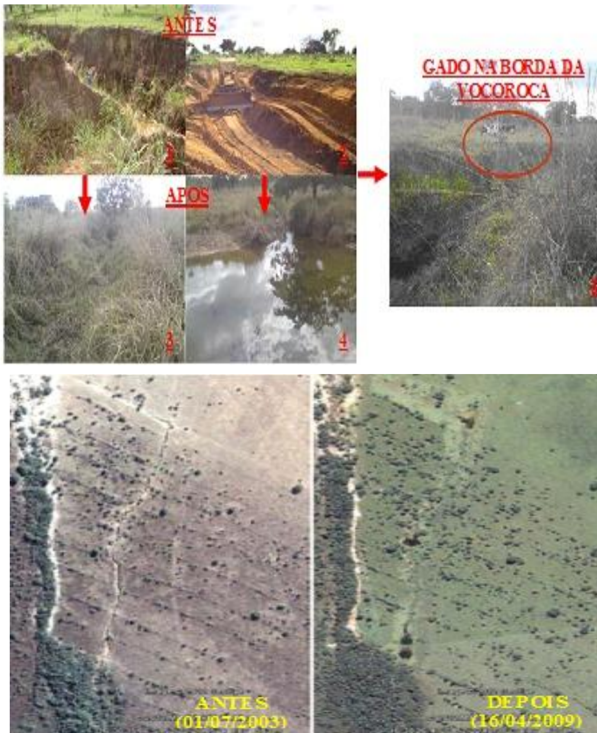
Figura 13. Condição da voçoroca “antes” e “após” a intervenção e sua condição atual.
