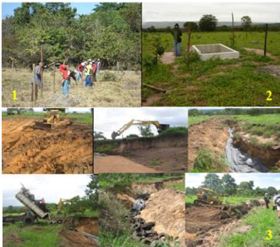
Figura 9. Práticas mecânicas para a recuperação da voçoroca. (1 - Instalação da cerca de isolamento; 2 - construção de tanques de dessedentação para o gado; 3 - retaludamento, colocação dos pneus e construção do dreno).
