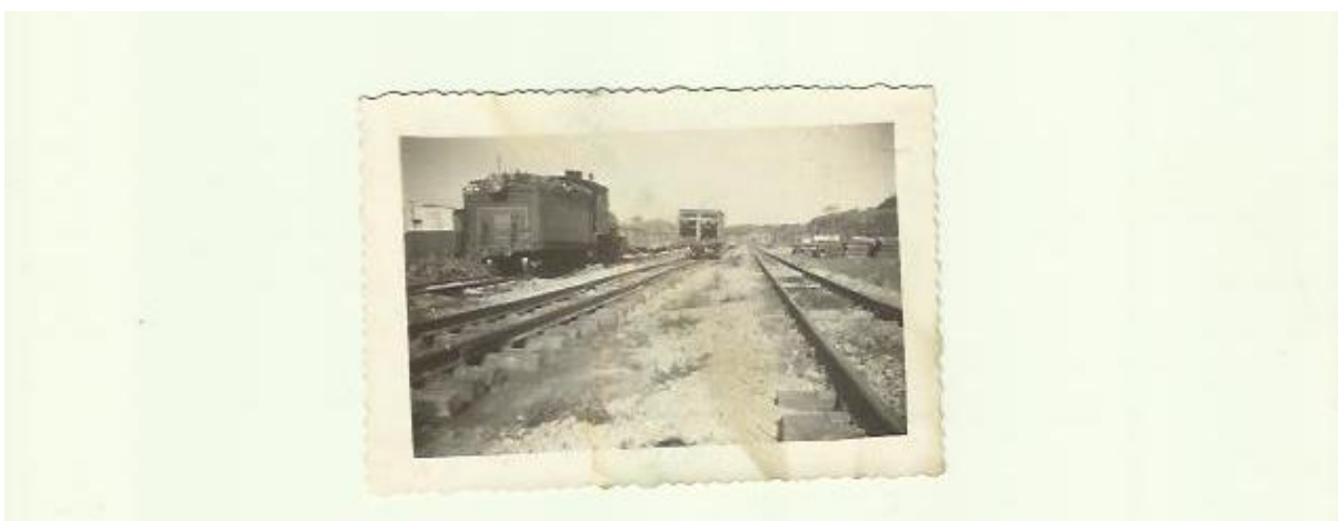
Foto 2. Obras de manutenção dos trilhos da Estrada de Ferro de Goiás. Fonte: Museu Ferroviário de Pires do Rio.
