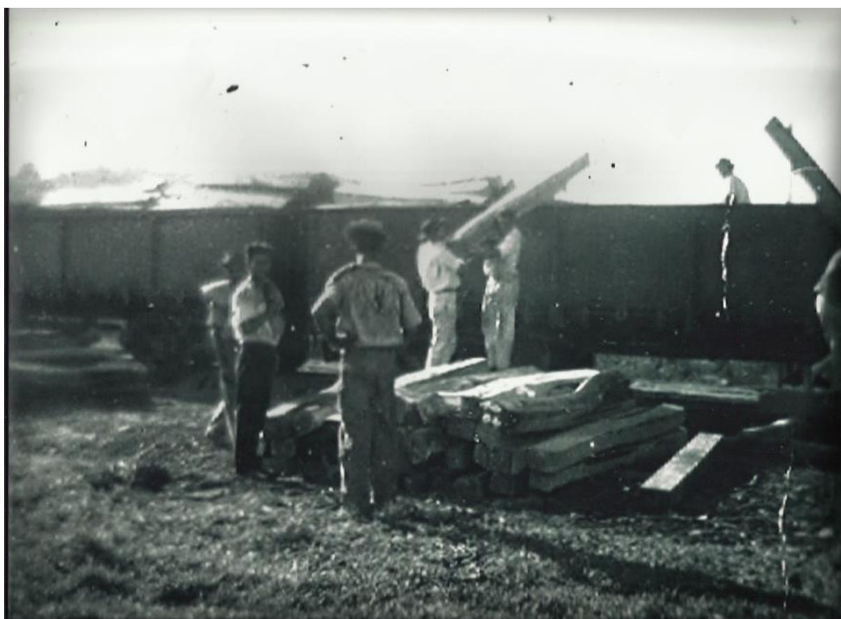
Foto 4. Movimentação de dormentes na Estrada de Ferro de Goiás. Fonte: Museu Ferroviário de Pires do Rio.
