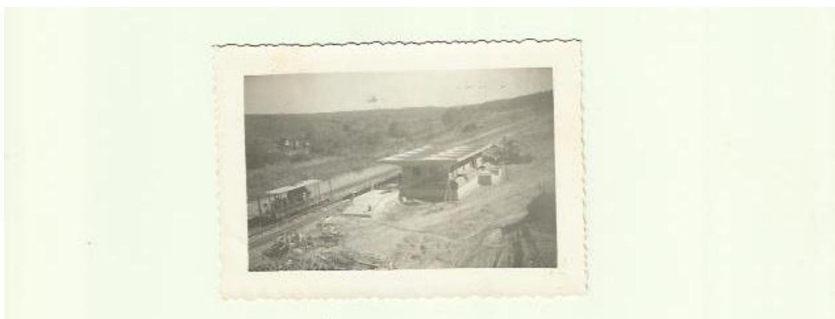
Foto 3. Máquina para instalação de trilhos na Estrada de Ferro de Goiás. Fonte: Museu Ferroviário de Pires do Rio.
