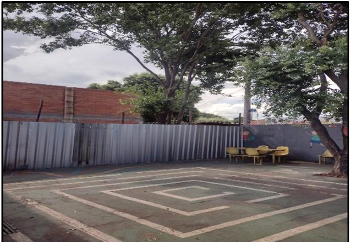
Figura 2 – Espaço externo da escola com construção da sala de aula
