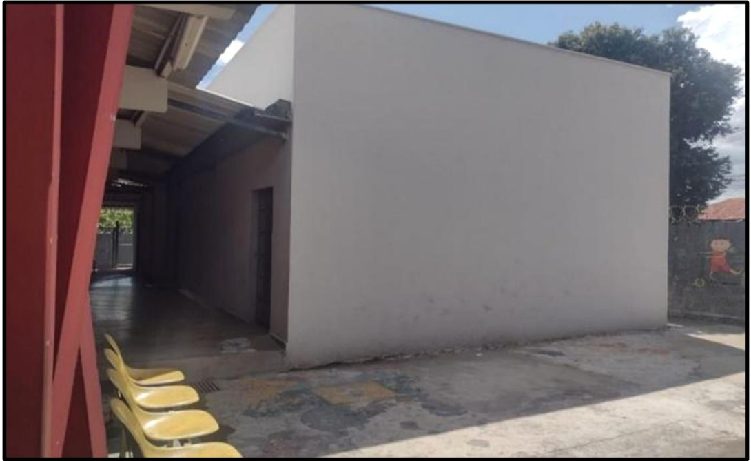
Figura 3 – Espaço externo da escola com sala de aula finalizada
