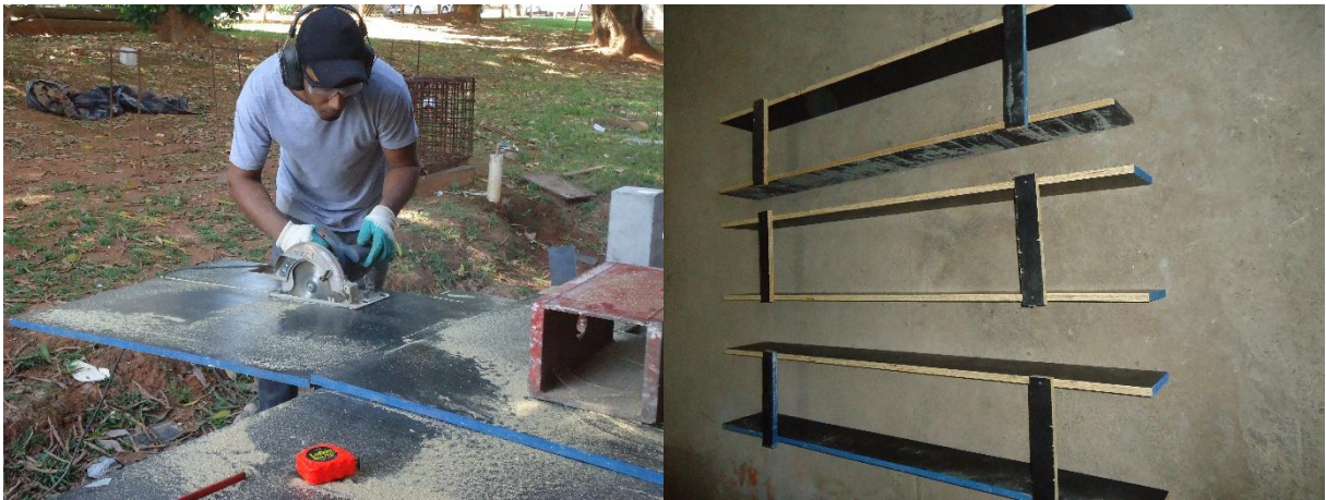
Figura 37 – Corte e preparo da forma para montagem
