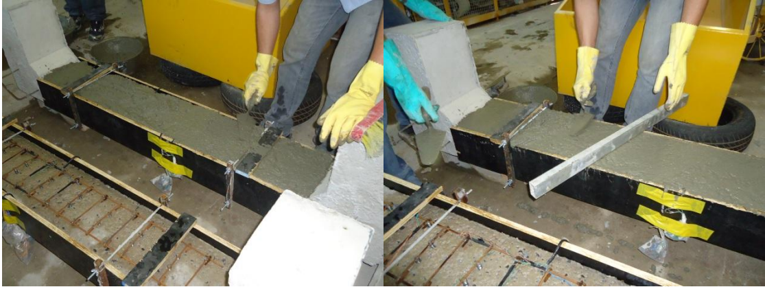
Figura 59 – Espalhamento do concreto e acabamento inicial
