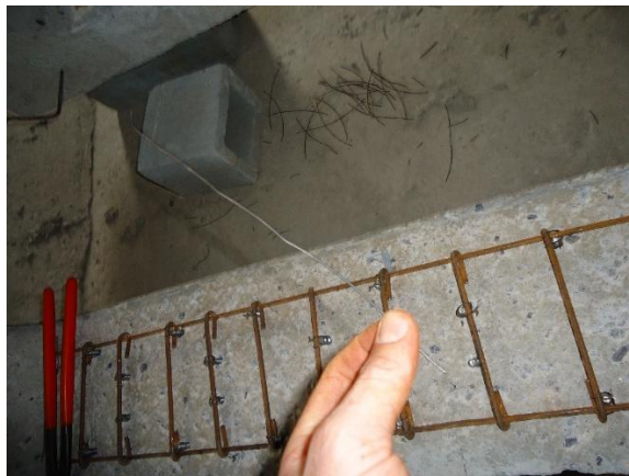
Figura 42 – Detalhe do arame e armadura de pele montada
