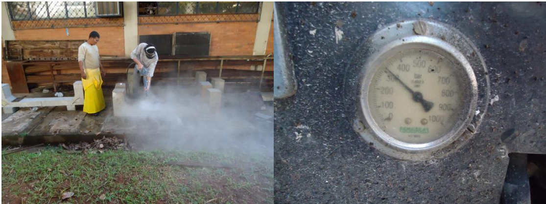
Figura 54 – Escarificação da superfície à ser reforçada (substrato)
