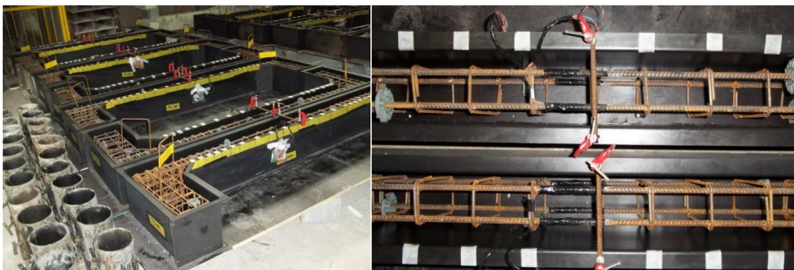
Figura 39 – Armadura dos pilares montada (substrato) (FERREIRA, 2014)
