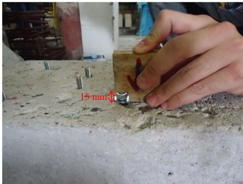
a) Verificação da altura dos chumbadores
