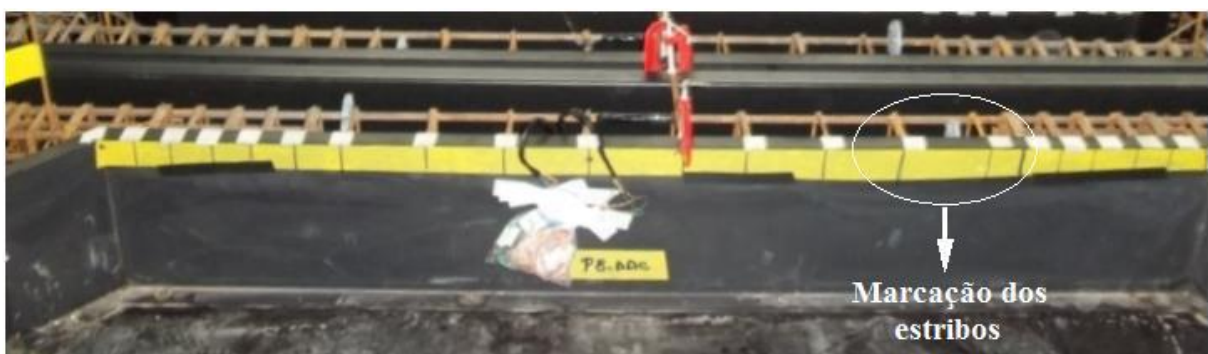
Figura 36 – Marcação da posição dos estribos (FERREIRA, 2014)
