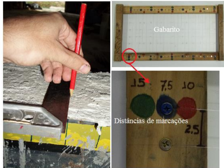
Figura 51 – Marcação dos estribos e detalhe do gabarito
