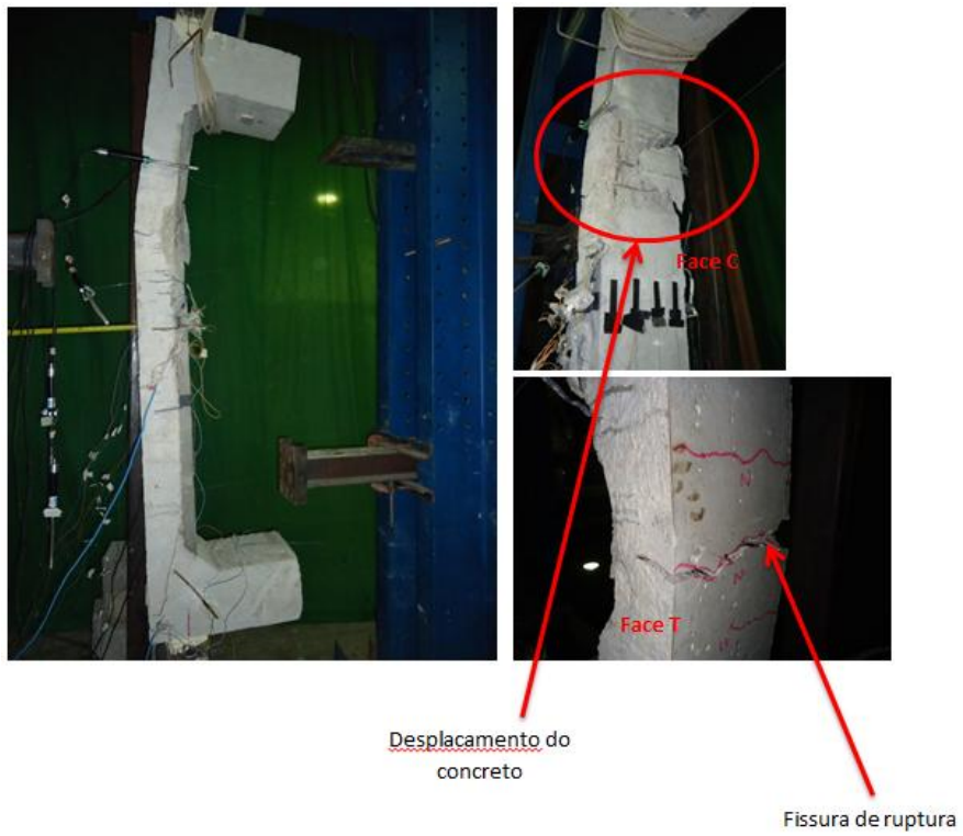
Figura 93 - Região de ruptura do pilar reforçado P2
