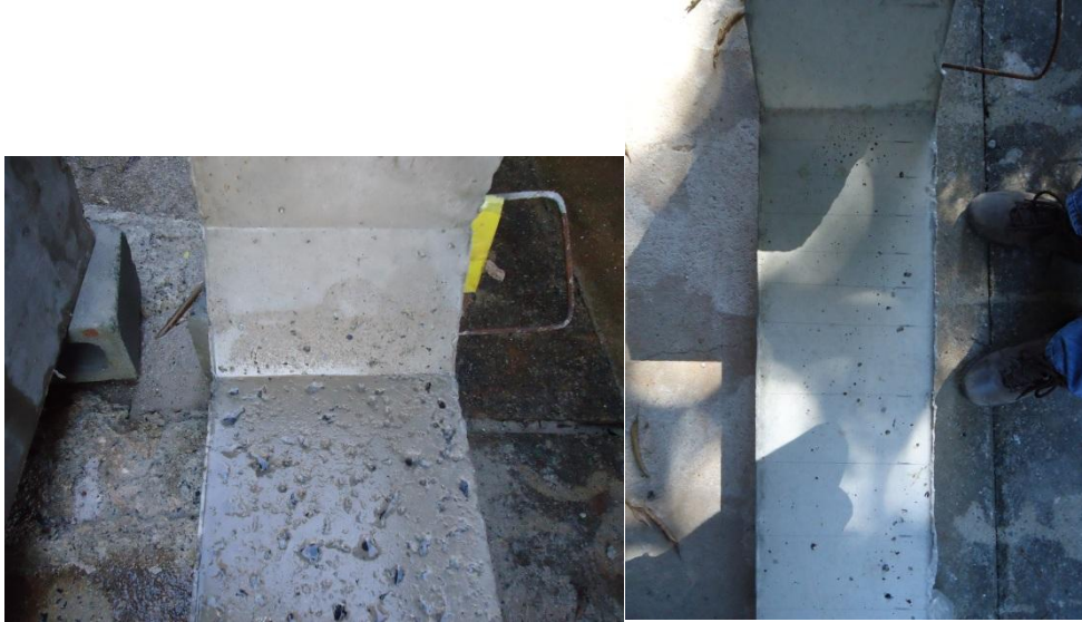
Figura 55 – Superfície escarificada e superfície sem escarificação
