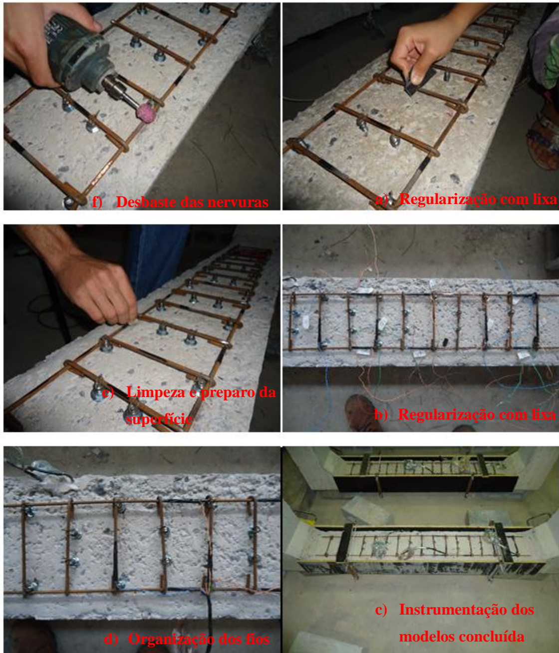
Figura 62 – Colagem de extensômetros na armadura
