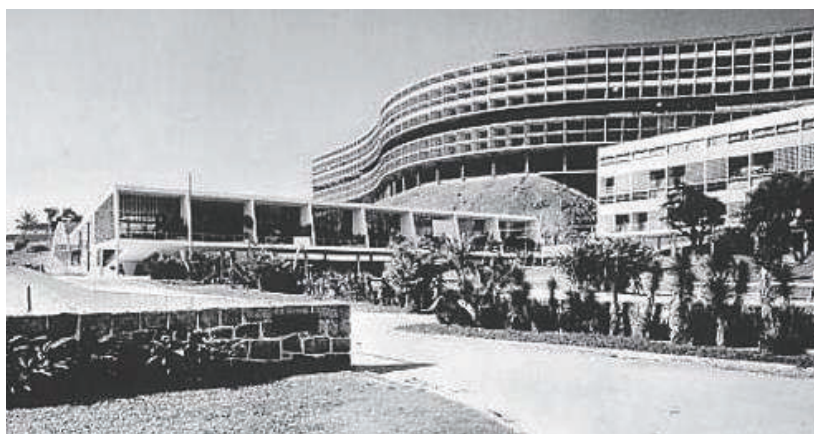
Figura 36: Conjunto Habitacional Pedregulho, 1951. Fonte: http://www.archdaily.com.br/br/01-12832/classicos-da-arquitetura-conjunto-residencial-prefeito-mendes-de-moraes-pedregulho-affonso-eduardo-reidy/12832_12880 . Acessado em: 25 set. 2015
