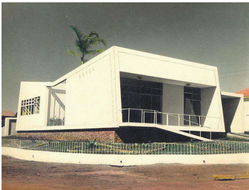
Figura 40 - Primeira Casa Moderna de Goiânia, 1952 – Residência demolida. Fonte: Acervo Simone B. Camargo de Oliveira.
