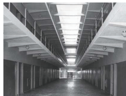
Figura 113 - Vista Interna do Pavilhão Principal CEPAIGO, 1962. Fonte: Acervo da família Calixto de Godoi.
