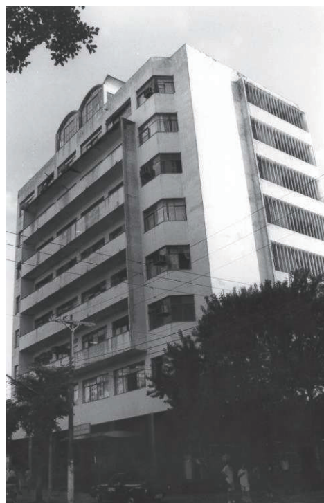
Figura 82 – Detalhe - Edifício Antiga Sede do IPASE, 1990. Fonte: Acervo Simone B. Camargo de Oliveira, 1990.
