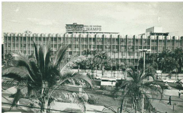
Figura 96 - Edifício Hospital Rassi, década de 1960. Fonte: IBGE – go4282.
