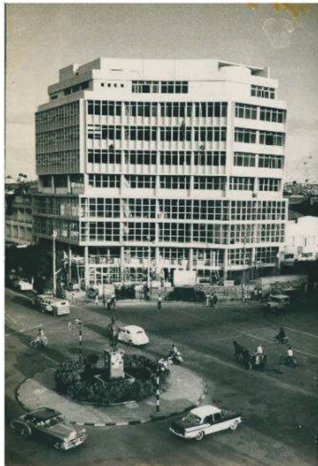
Praça [Atílio] Corrêa Lima: Monumento ao Bandeirante: vista parcial da cidade: Goiânia, GO - [19--] - Antiga Sede do Banco do Estado de Goiás S/A. Fonte: IBGE- go 42667.
