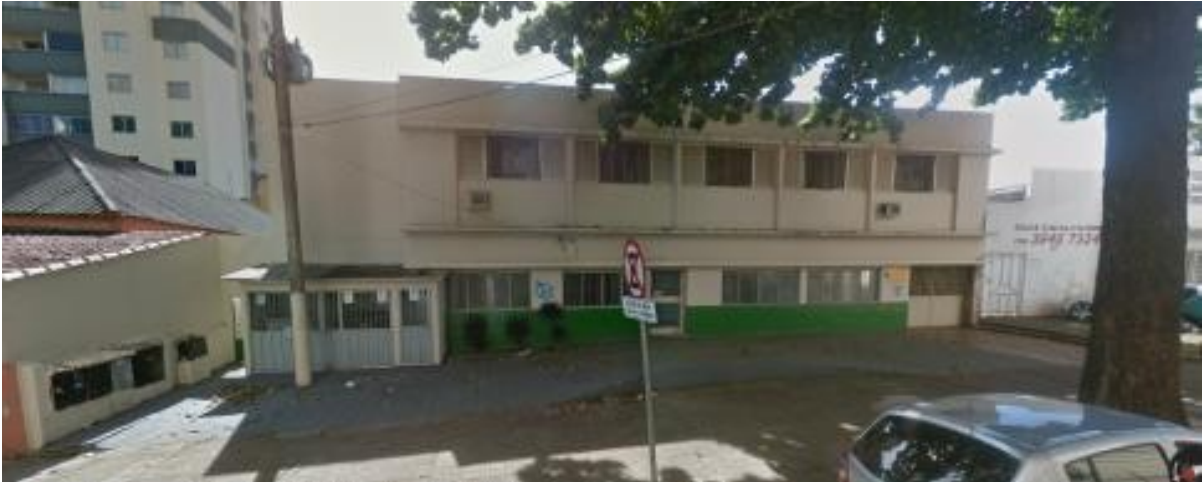
Figura 41: Antigo Hospital Maria Auxiliadora na Rua 20 no ano de 2017.
