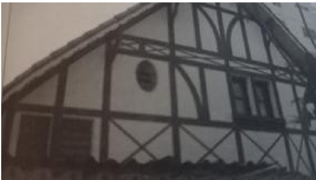
Figura 31: Residência na Rua 20, n°220, quadra 49 e Lote 34 em 2006.
