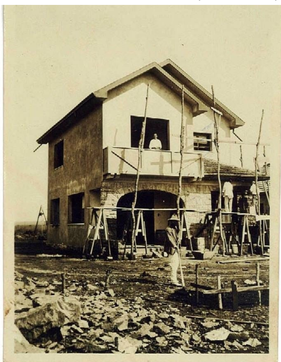
Figura 13: Construção da casa do Dr. Benjamim Vieira em 1933, posteriormente esse local se tornou a Faculdade de Direito e em 2024 faz parte do complexo da Justiça Federal.
