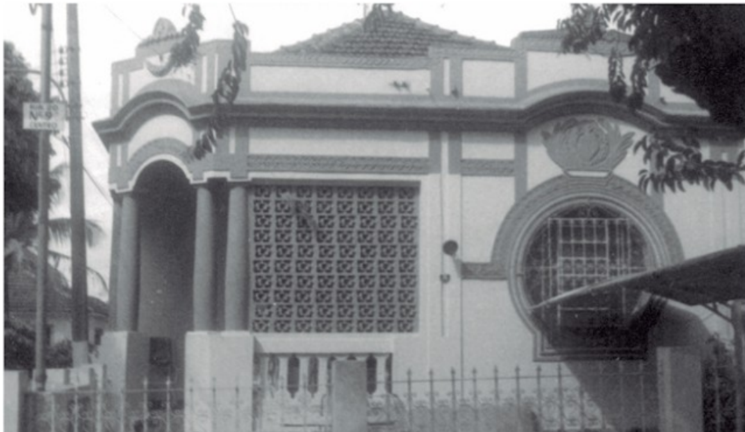
Figura 28: Residência eclética na Rua 20 em 1986. 38
