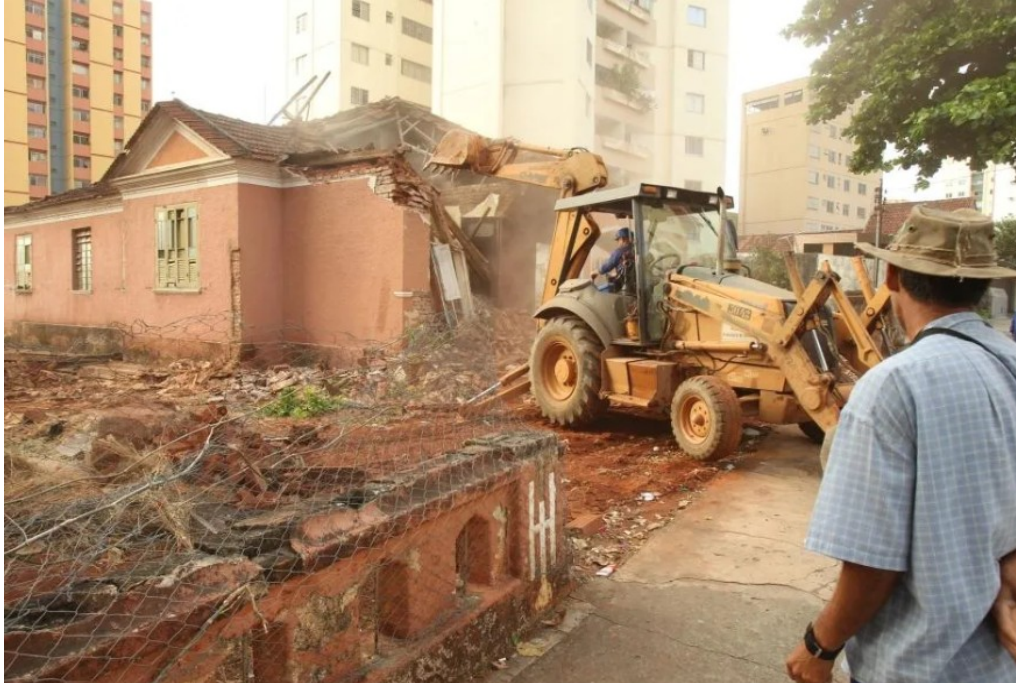
Figura 27: Casa histórica demolida no centro de Goiânia.
