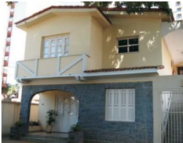
Figura 16: Foto da Ed. da Justiça Federal Rua 20, Quadra. 34 Lotes 19/21/31, Centro em 2006.
