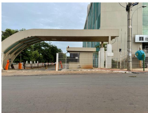
Figura 11: Entrada lateral do Fórum onde se localiza o Tribunal do Júri objeto desta Investigação para acesso das viaturas/dos camburões de transporte dos acusados presos Fonte: acervo fotográfico da pesquisadora.
