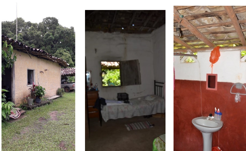
Fig.00: alicerce de pedra de rio ao longo de todo perímetro da casa, servindo de berço para receber as toras de aroeira pra gaiola em todo seu redor, saindo os degraus de lajes de pedra por debaixo do alicerce ajustando o terreno ao nível da casa. O sistema estrutural básico por peças verticais em madeira e horizontalmente o baldrame cuidadosamente afastado do solo devido a umidade. Dita/Militão
