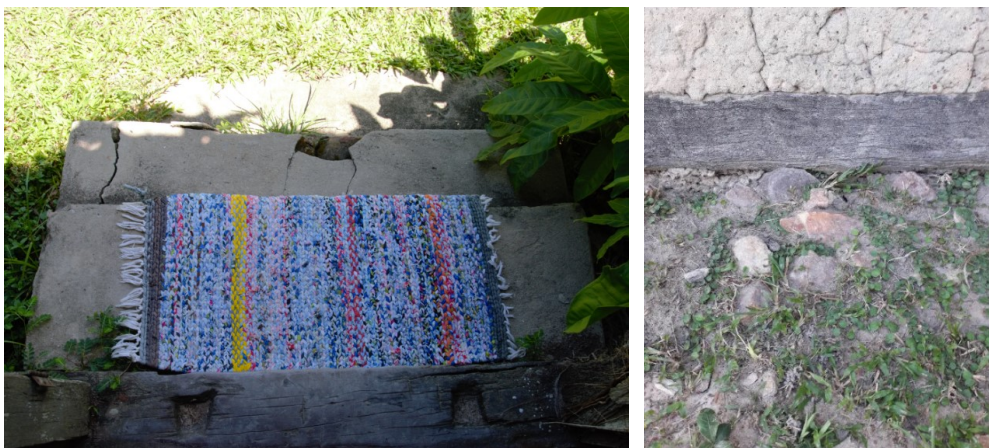
Fig.00: alicerce de pedra de rio ao longo de todo perímetro da casa, servindo de berço para receber as toras de aroeira pra gaiola em todo seu redor, saindo os degraus de lajes de pedra por debaixo do alicerce ajustando o terreno ao nível da casa. O sistema estrutural básico por peças verticais em madeira e horizontalmente o baldrame cuidadosamente afastado do solo devido a umidade. Dita/Militão
