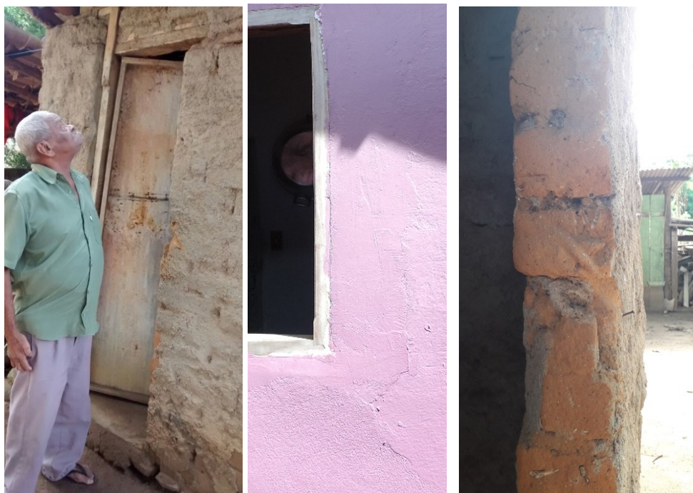
Fig.00a: paredes em tijolos de adobe, Sr Inocêncio
