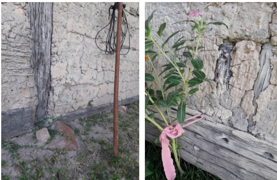
Fig.00: alicerce de pedra de rio ao longo de todo perímetro da casa, servindo de berço para receber as toras de aroeira pra gaiola em todo seu redor, saindo os degraus de lajes de pedra por debaixo do alicerce ajustando o terreno ao nível da casa. O sistema estrutural básico por peças verticais em madeira e horizontalmente o baldrame cuidadosamente afastado do solo devido a umidade. Dita/Militão
