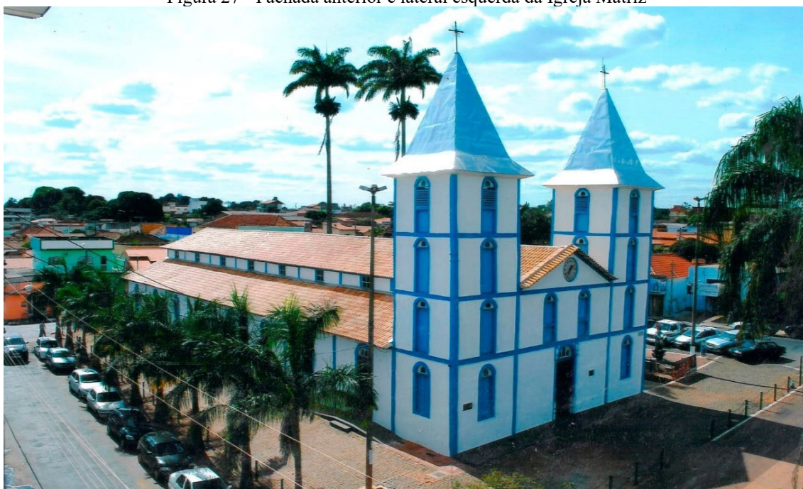
Figura 27 - Fachada anterior e lateral esquerda da Igreja Matriz
