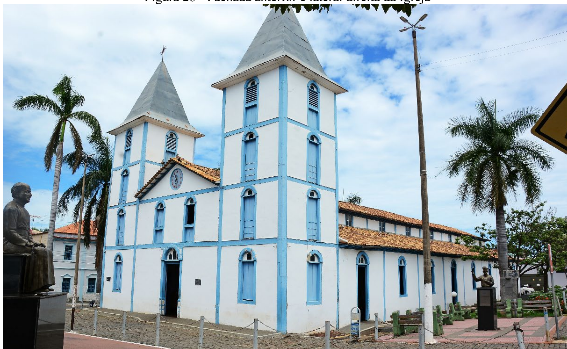
Figura 26 - Fachada anterior e lateral direita da Igreja
