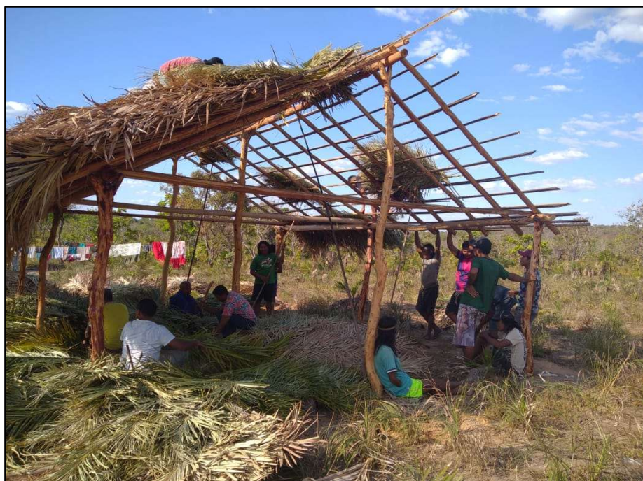
Imagem 25 - Construção da minha casa na Aldeia Sol
