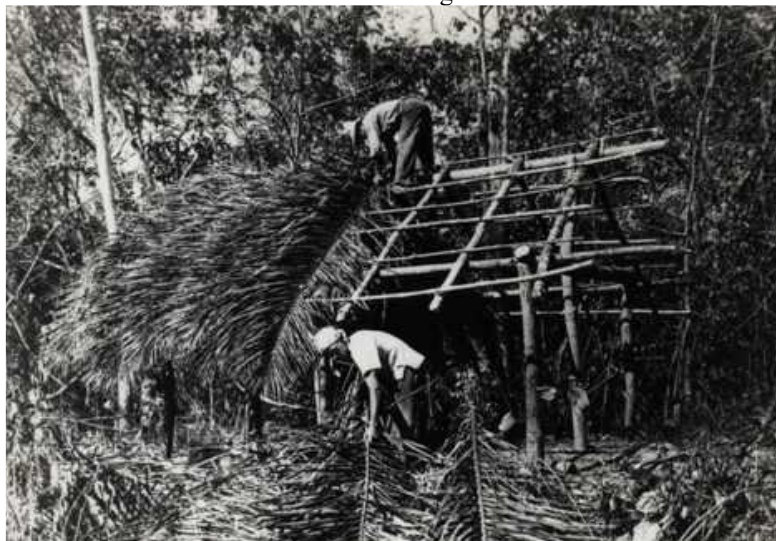
Figura 5 - Cabana (Trabalhadores construindo suas moradas). Goiânia, 1936. Fotografia de Alois Feichtenberger
