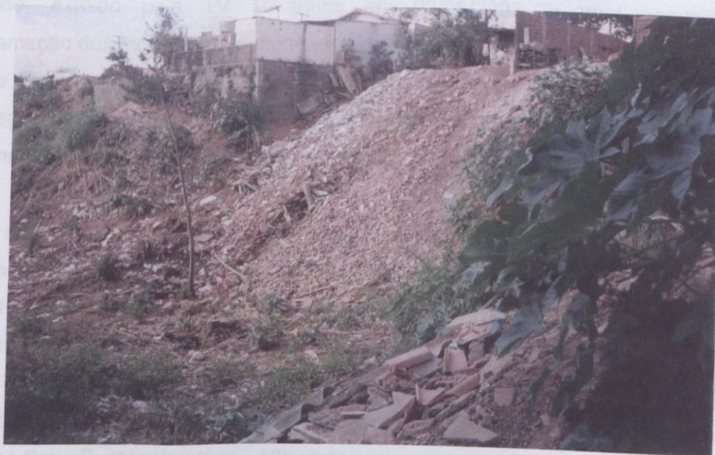
Foto 12- Detalhe do talude de uma boçoroca de grandes proporções apresentando desmoronamentos, com risco de desabamento das casas adjacentes. Bairro São Lourenço.
