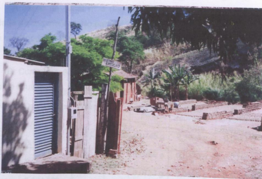
Foto 23 – Olaria próxima às margens do córrego Catingueiro, acumulando entulhos com intuito de conter o solapamento das margens. Bairro Jardim Petrópolis.
