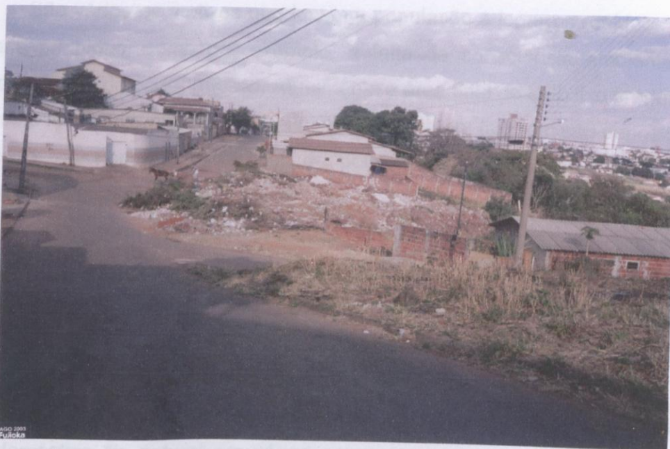
Foto 11- Depósito de lixo e entulho com intuito de conter a atividade erosiva. As ruas estão voltadas em direção à área problema. Rua José Gomes de Paula, Bairro São Jorge.
