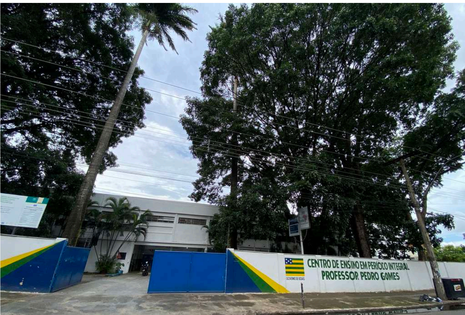
Figura 4 - Fachada do CEPI Prof. Pedro Gomes – Fonte: arquivo da escola - 2023
