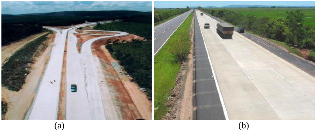
Figura 2. 7 – Rodovias recuperadas com whitetopping: (a) Rodovia SP-79/103; (b) Rodovia BR-290 (conhecida por Free Way)
