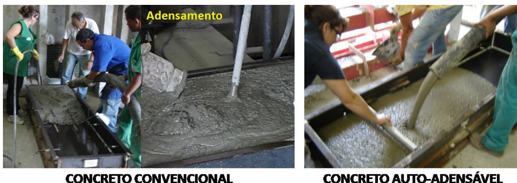
Figura 3. 11 – Concretagem, adensamento e nivelamento
