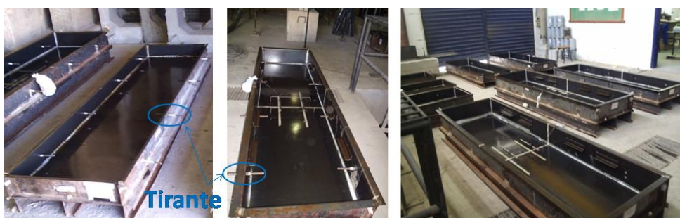
Figura 3. 10 – Formas metálicas preparadas para a concretagem
