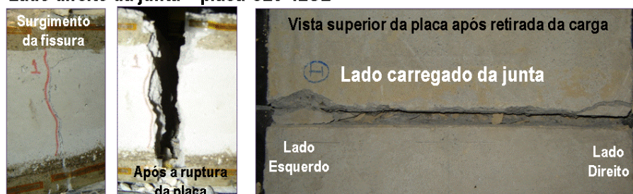
Figura 4.6 – Etapas da fissuração da placa C20-12B
