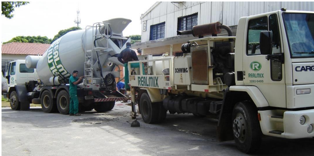
Figura 3.3 – Fornecimento de concreto usinado pela Realmix
