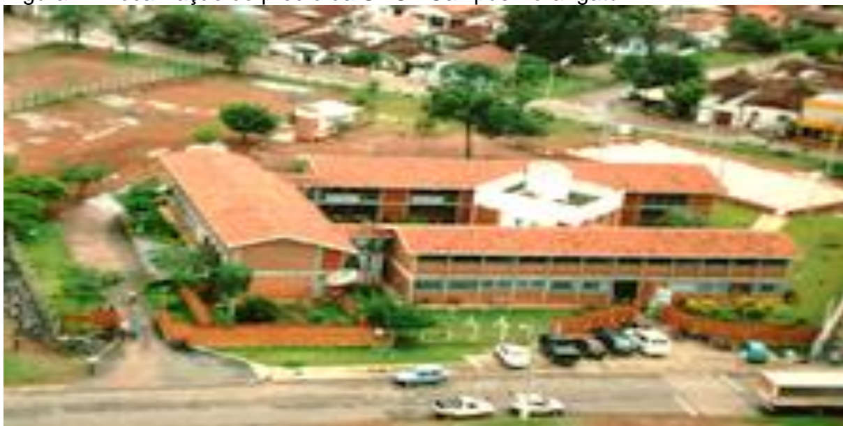
Figura 2 - Localização do prédio da UEG– Campus Porangatu.
