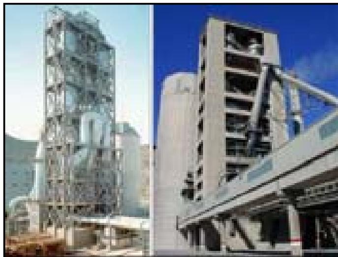
**Figura 4.3:** Vista geral de uma fábrica de cimento, com destaque para pré-aquecedores e pré-calcinadores (SIMAI, 2005)
