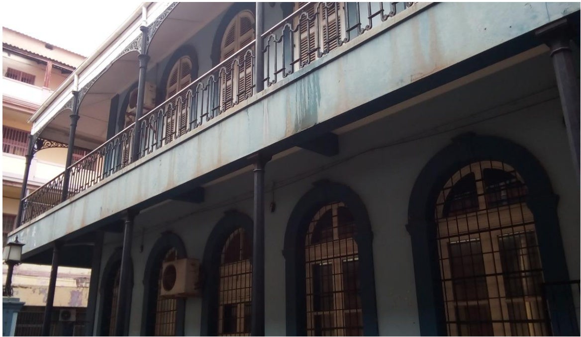
Figura 40: Fachada do edifício do ARPAC na cidade de Maputo 2019. Fotos do autor.
