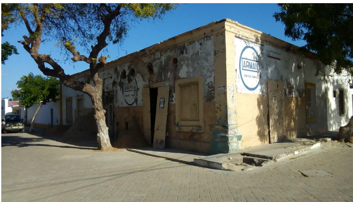
Figura 59: Obra em armazém em frente ao mercado Municipal da Ilha de Moçambique 2019. Foto do autor.
