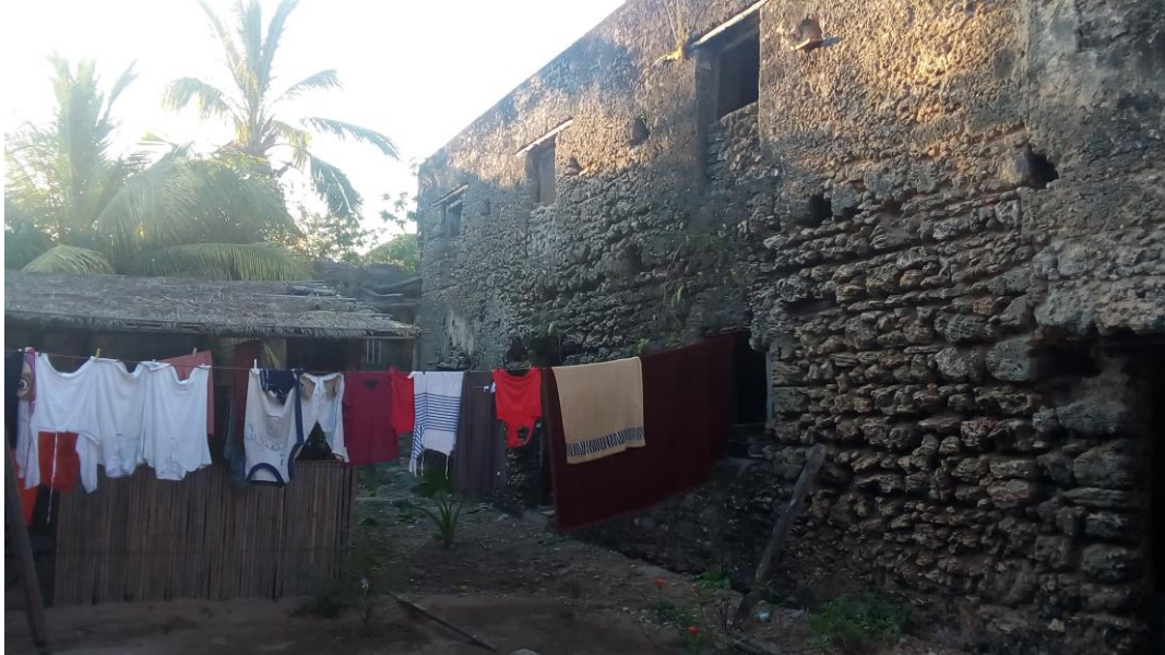
Figura 103: Quintal da casa do xeique com detalhe para o muro feito de pedra de coral 2019. Foto do autor.
