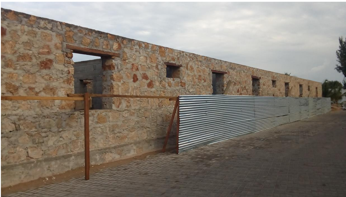
Figura 56: Instalação de tapumes 2019. Foto do autor.
