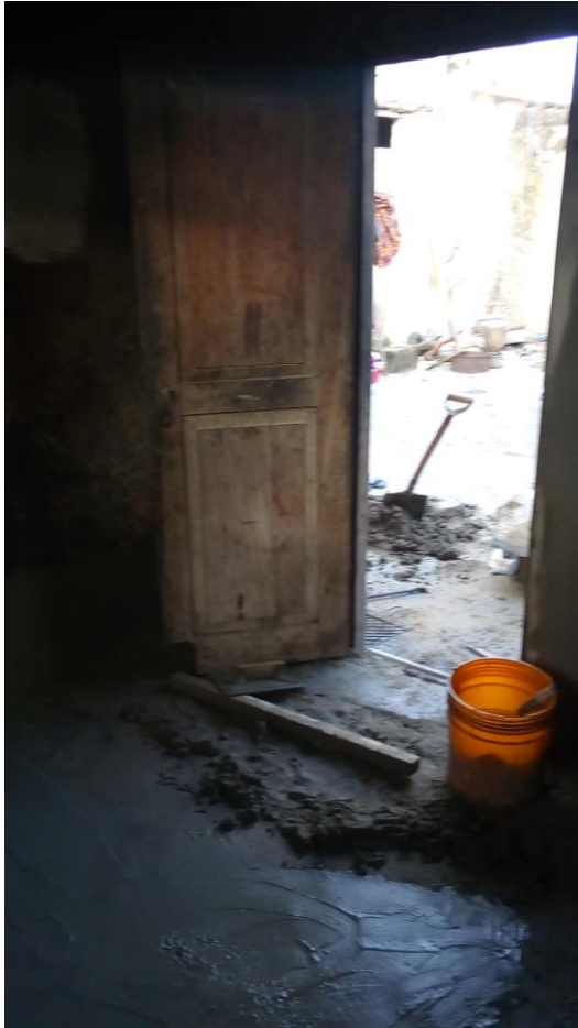
Figura 70: Obra para instalação de piso dentro de uma casa de macuti em processo de modificação 2019. Foto do autor.
