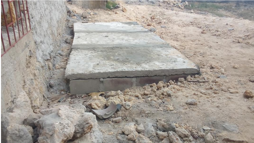
Figura 68: Caixas de fossas sépticas recém-construídas aos fundos de uma casa macuti já alterada 2019. Foto do autor.
