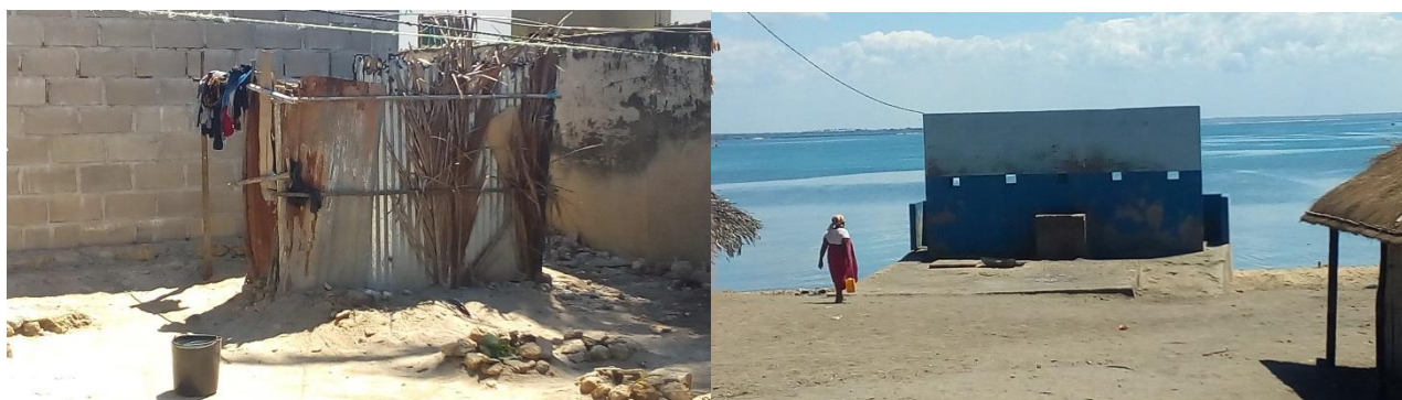
Figura 93: Na imagem da esquerda um modelo de “casa de banho”, um lugar para se tomar banho com o balde. Na imagem da direita um modelo de banheiro com sanitário 2019. Fotos do autor.
