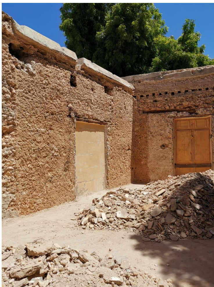
Figura 58: Descascando as paredes de um antigo armazém 2019. Foto de Didi.
