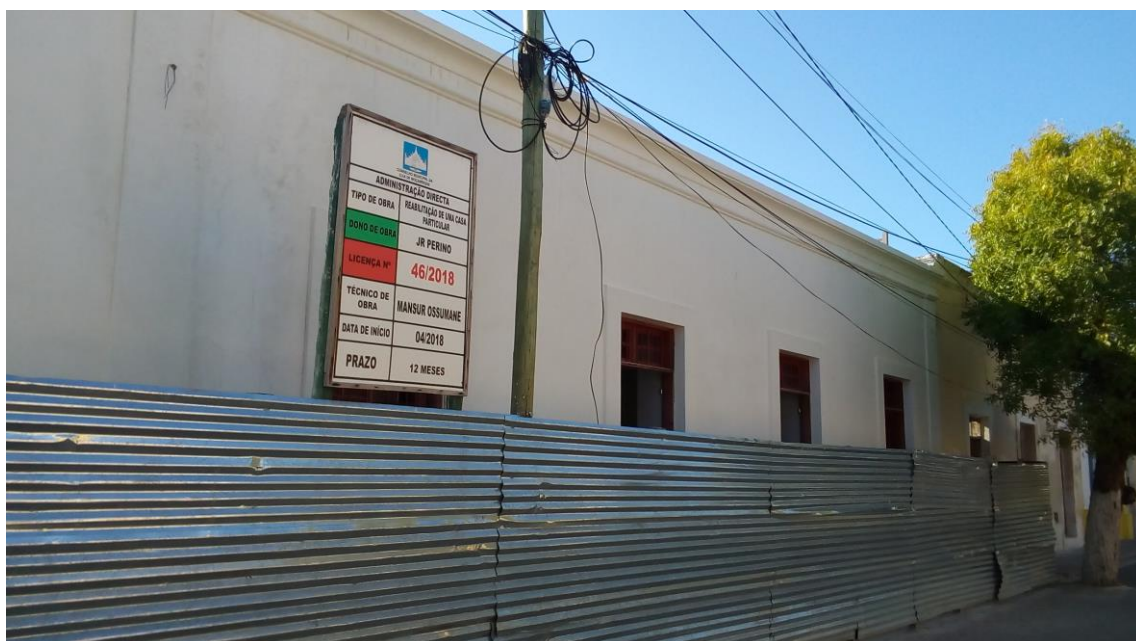
Figura 57: Obras em casa próximo ao Hotel Escondidinho 2019. Foto do autor.
