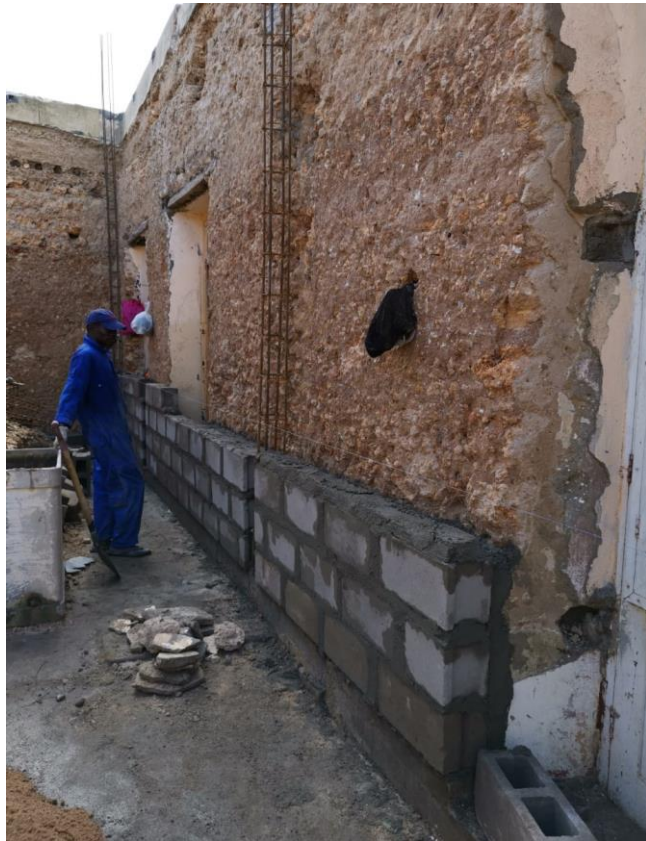
Figura 61: Construção de parede de blocos de cimento dentro de um antigo armazém 2019. Foto de Didi.
