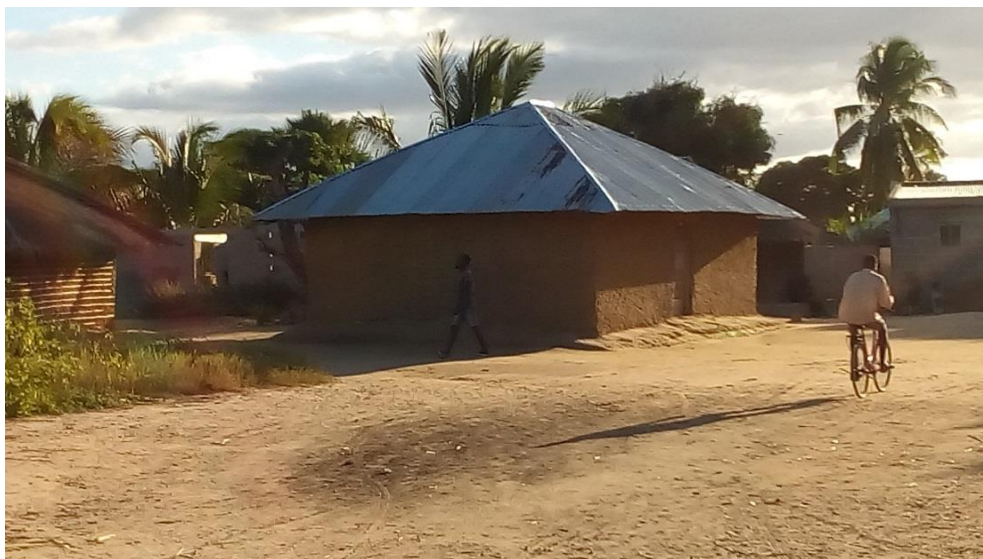
Figura 2: Essa é uma casa localizada no continente, que exemplifica um modelo que substituiu os materiais tradicionais de produção por paredes com blocos de concreto e com telhado de quatro águas de zinco, 2019. Foto do autor.
