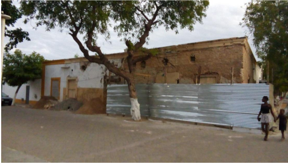
Figura 64: Antigo armazém em reforma para se tornar uma casa de férias 2019. Foto do autor.
