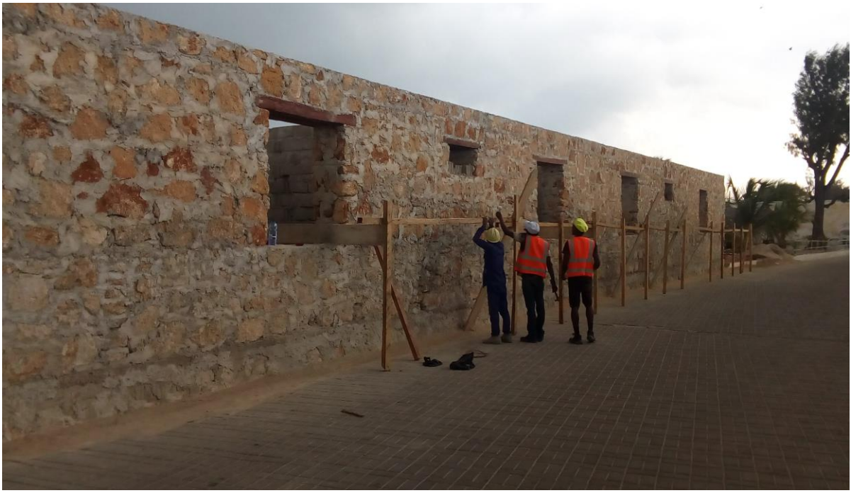
Figura 55: Obras na orla da contracosta 2019. Foto do autor.
