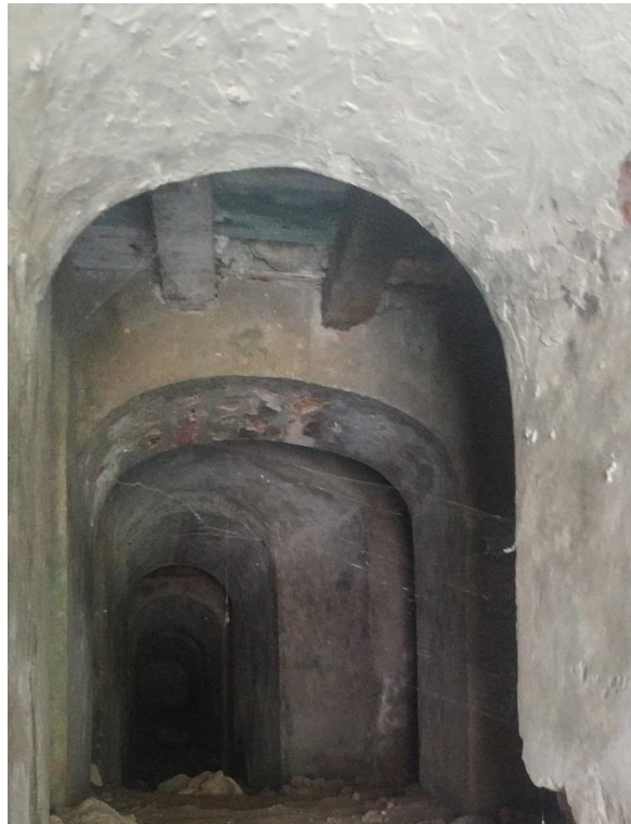
Figura 21: Túnel embaixo de uma mesquita no bairro Litine na cidade de Macuti 2019. Foto do autor.
