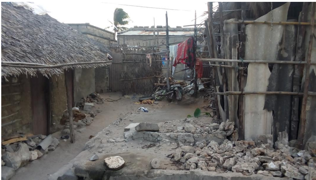
Figura 67: Detalhe para casas macuti rodeadas por casas com paredes de bloco de concreto, padras de coral usadas na manutenção das casas e uma casa de banho ao meio 2019. Foto do autor.
