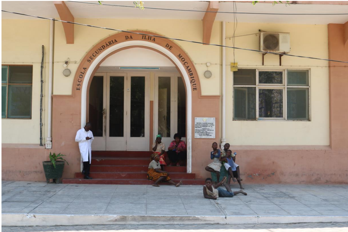
Figura 9: Entrada da Escola Secundária da Ilha de Moçambique 2019. Foto do autor.
