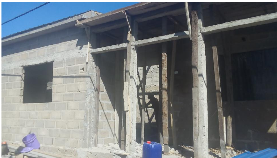
Figura 66: Obra na cidade de Macuti 2019. Foto do autor.
