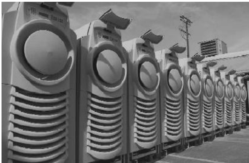
Figura 4.5: Conjunto de microturbinas instaladas em planta industrial.
