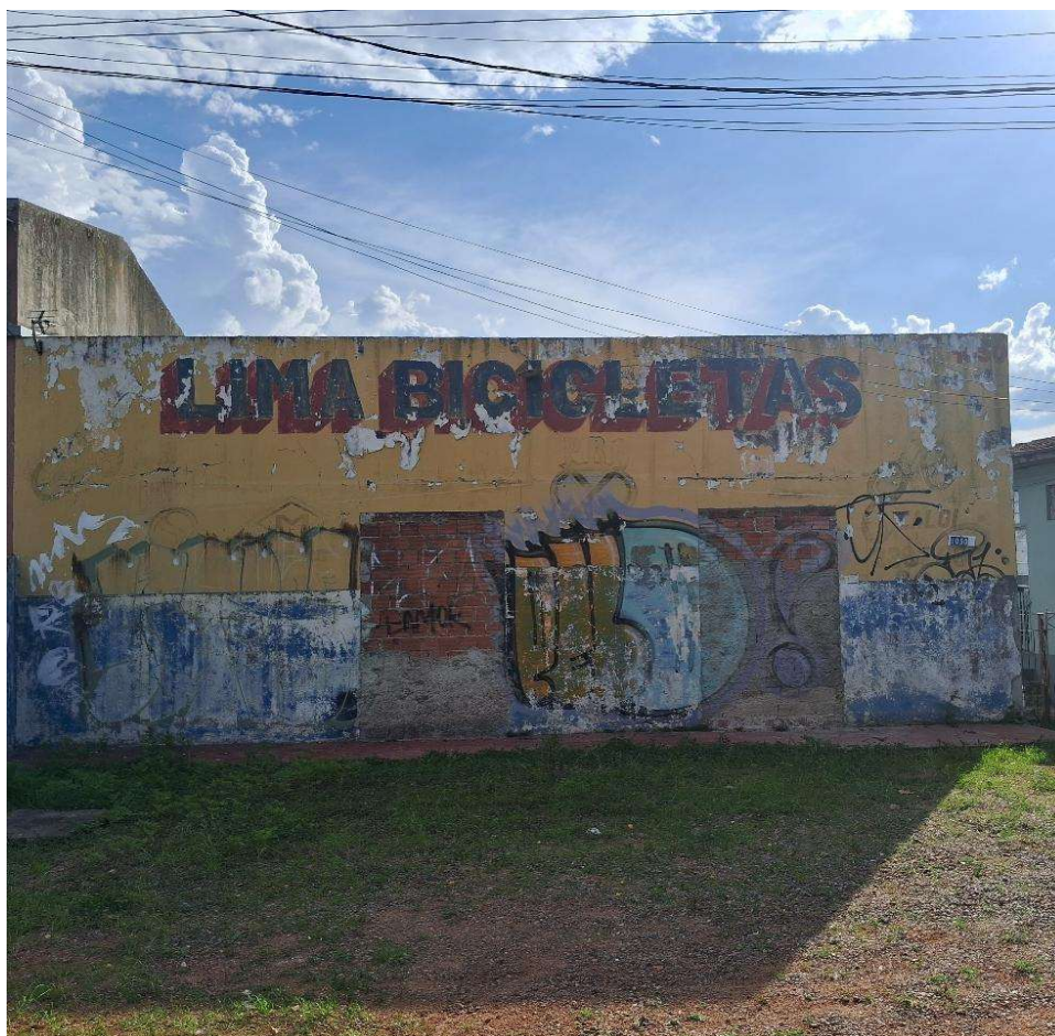
Figura 54 – Fotografia de estabelecimento comercial demolido no Bairro Alto
