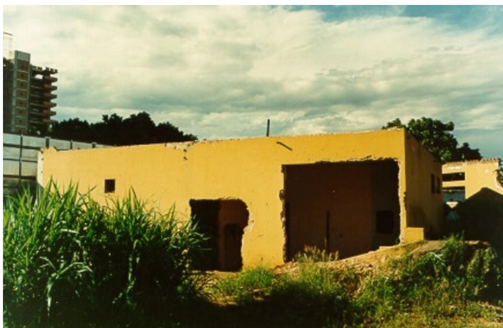
Figura 1 – Escombros da clínica do Instituto Goiano de Radiologia em 1987
