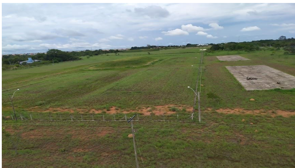
Figura 17 – Depósito dos rejeitos radiológicos do Césio-137
