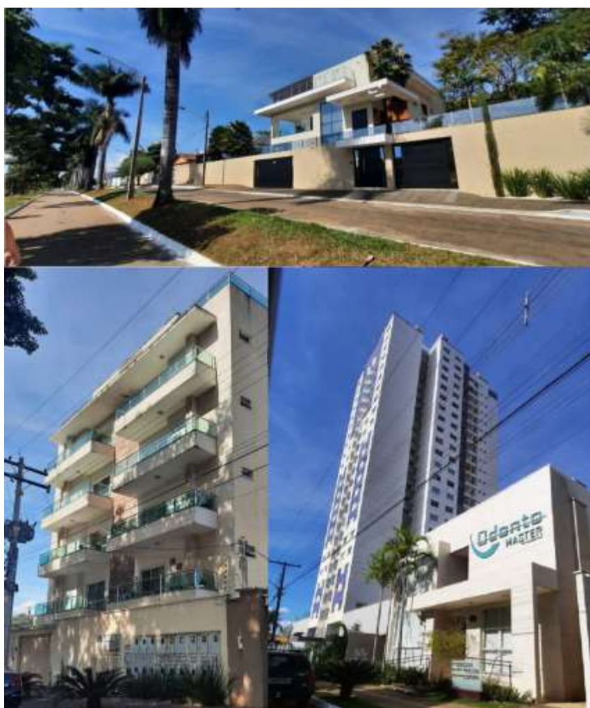
Figura 11 – Mosaico de Imagens de Construções verticalizadas próximas ao Parque Goiabeiras em Inhumas
