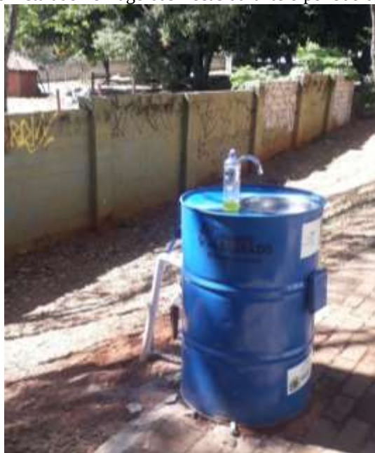
Figura 231 – Lavatório instalado no Lago das Rosas durante o período de pandemia da Covid-19
