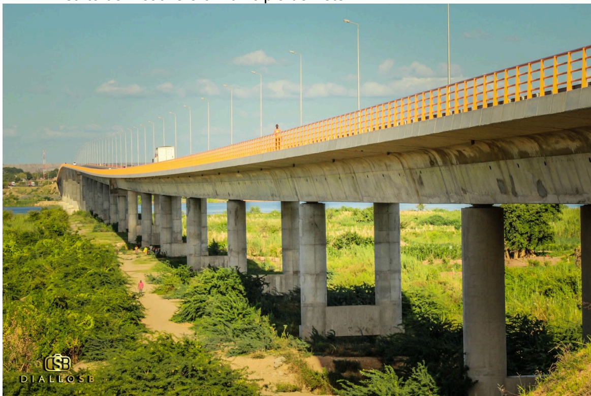
Foto 5 - Vista lateral da Ponte Kassuende que estabelece a ligação entre o Distrito de Moatize e o Município de Tete
