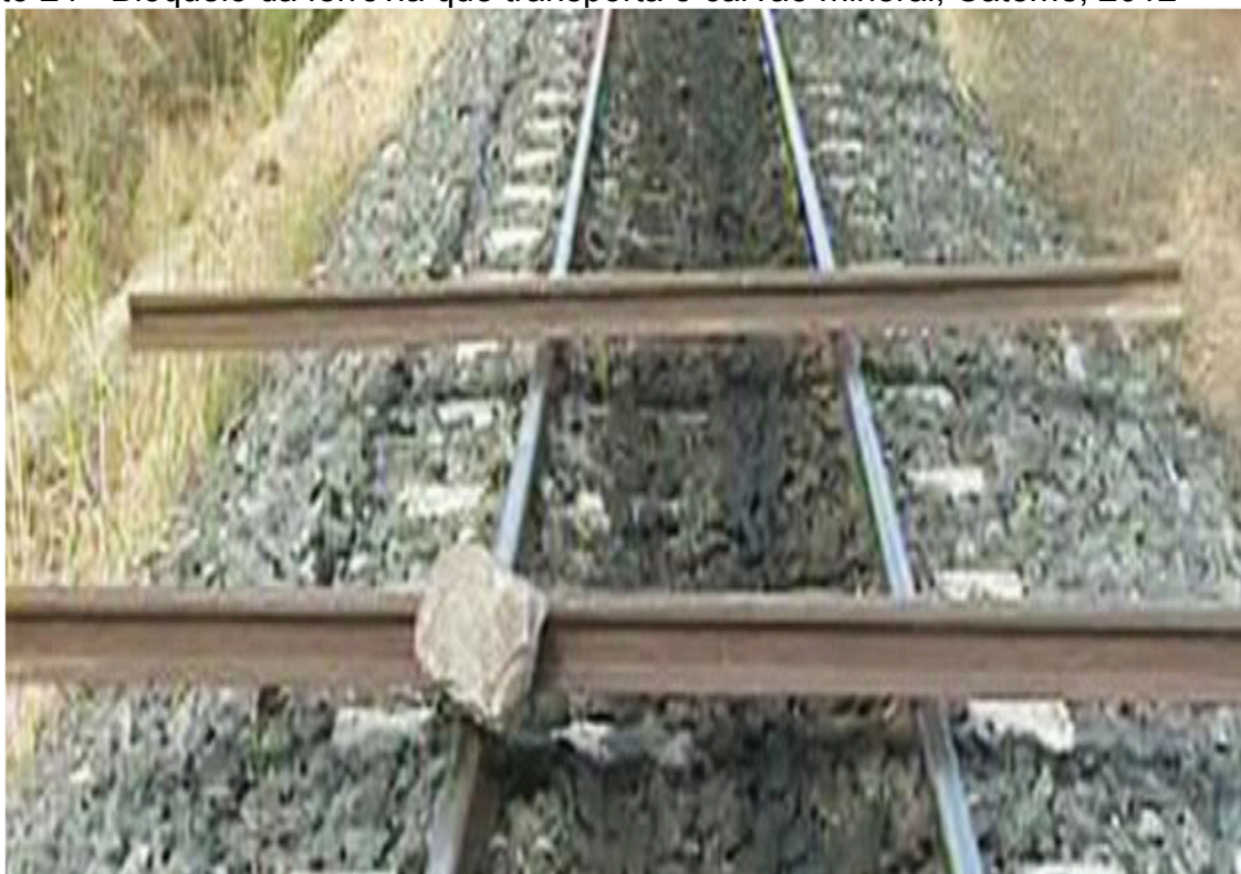
Foto 24 - Bloqueio da ferrovia que transporta o carvão mineral; Cateme, 2012
