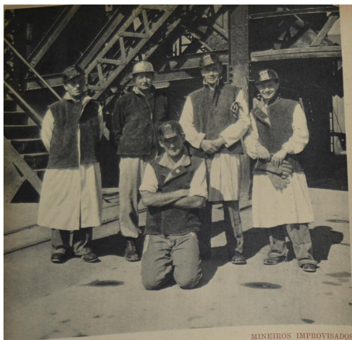
Figura 29. HG e equipe em trajes de operários mineiros na União Sul-Africana. Galvão demonstrava deslumbramento com a modernidade capitalista sul-africana e o progresso da ação humana sobre a paisagem natural. (in. Ronda de África)
