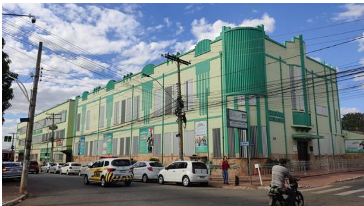
Figura 59. Colégio Santa Clara, bairro de Campinas.
