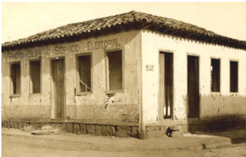
Figura 29. Estúdio fotográfico de Antônio Pereira da Silva (janelas à esquerda), 1935.
