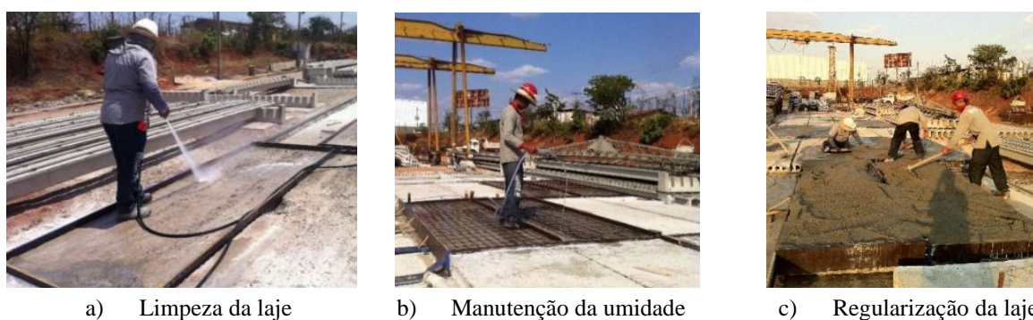
Figura 4.10 – Procedimento para capeamento das lajes.
