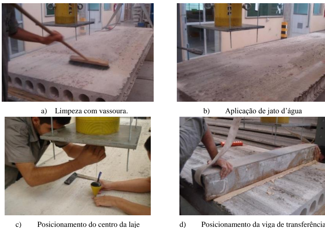
Figura 4.23 – Algumas etapas de limpeza e marcação da laje alveolar.
