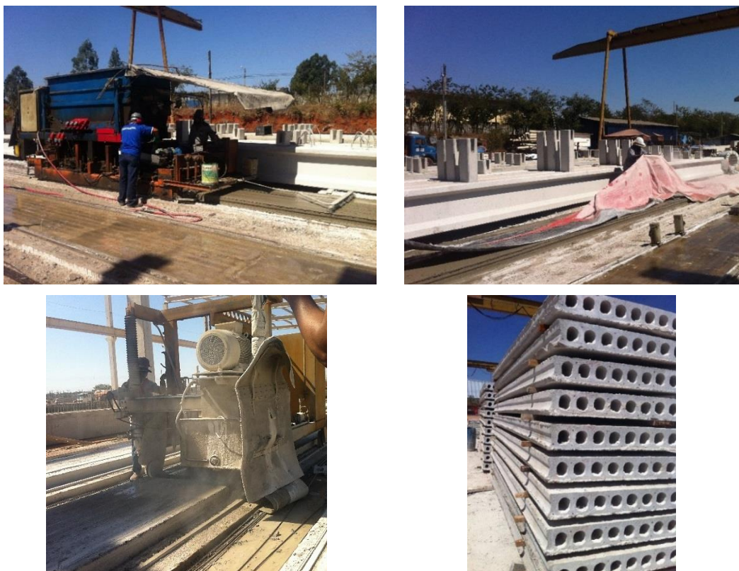
Figura 4.3 – Concretagem, corte e armazenamento das lajes alveolares
