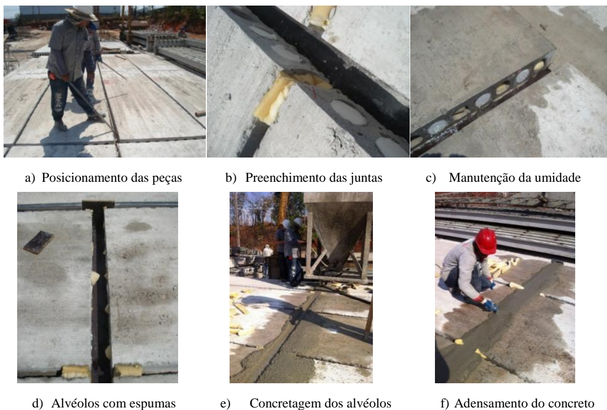
Figura 4.9 – Preenchimento parcial dos alvéolos das lajes.
