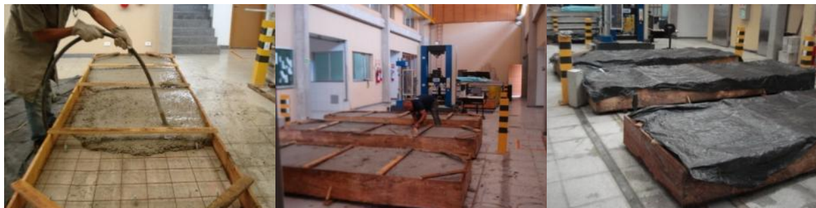
Figura 4.13 – Aplicação e adensamento do concreto.
