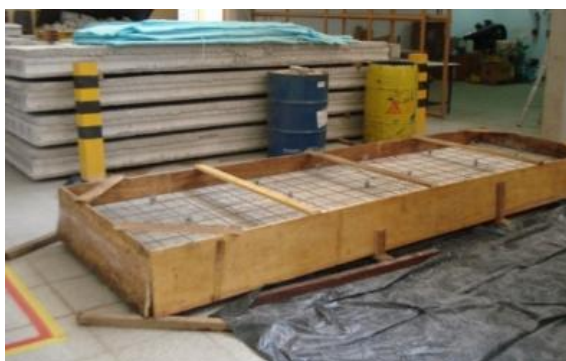
Figura 4.12 – Montagem e disposição das formas.
