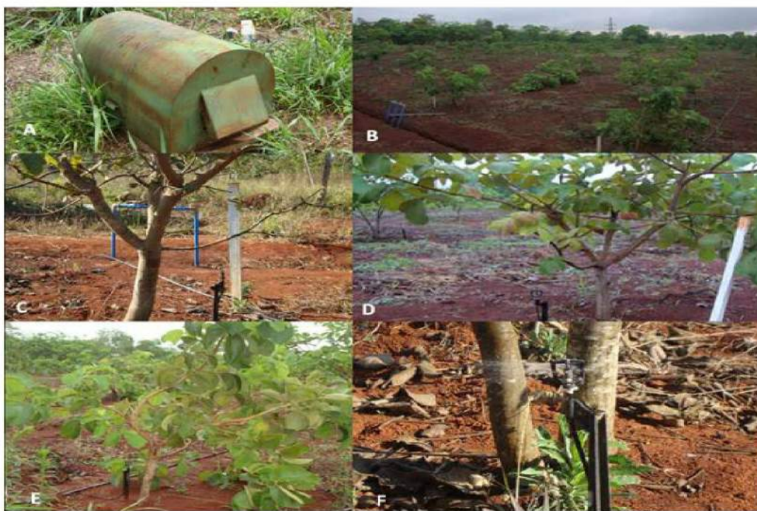
Figura 4. Detalhes do sistema de irrigação instalado no experimento, com destaque para o poço semi-artesiano instalado na área (A), valeta de 0,7 m de profundidade aberta manualmente para instalação das tubulações de PVC das linhas principal e derivação (B), cavalete 0,5 de altura utilizado para divisão da área em 2 setores e de uma linha lateral de polietileno (C), espaçamento ( 5 \times 5 \text{ m} ) entre plantas e entre emissores (D), importância da poda de ramos que obstruíam o jato de água (E) e microaspersor em funcionamento (F).
