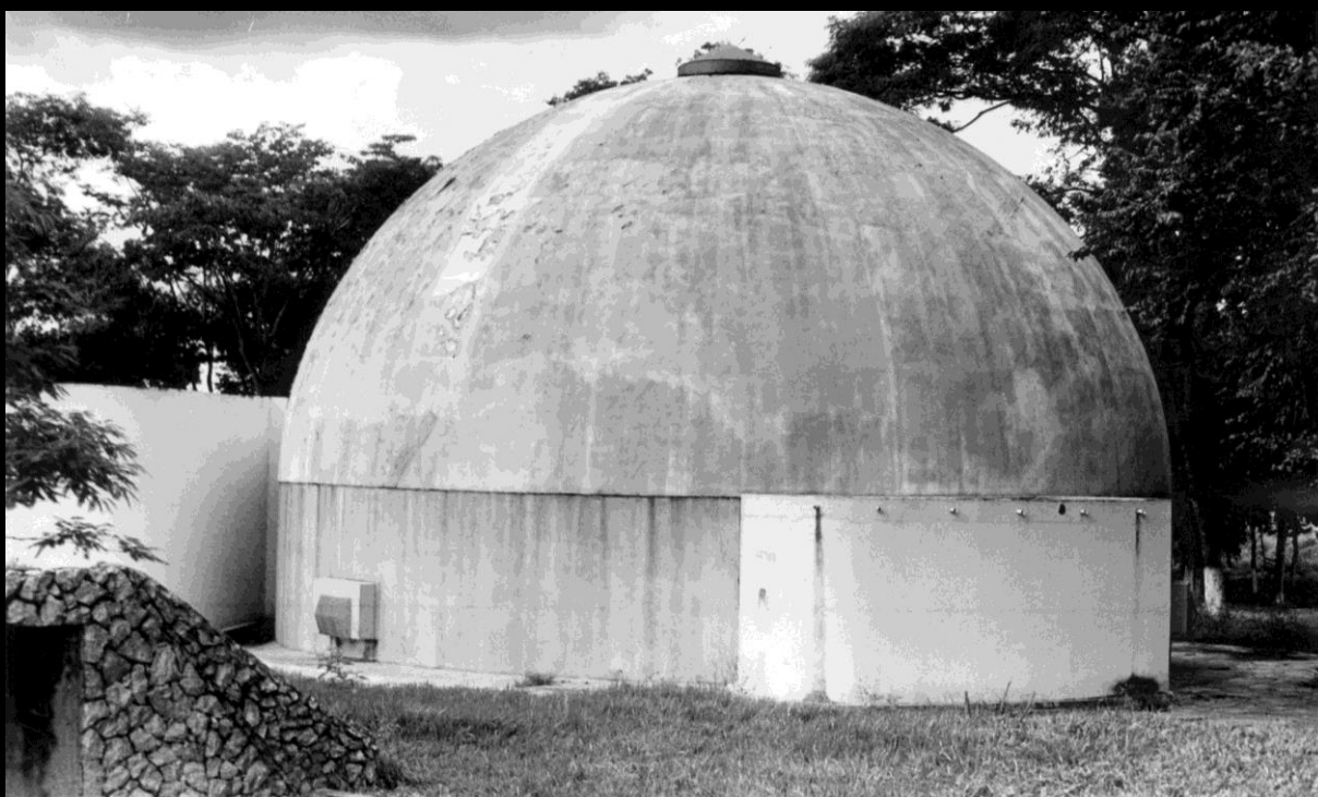
Figura 26 – Edifício do Planetário em 1971. Fonte: Site oficial do Planetário da UFG. Disponível em: < https://www.planetario.ufg.br/ >.
