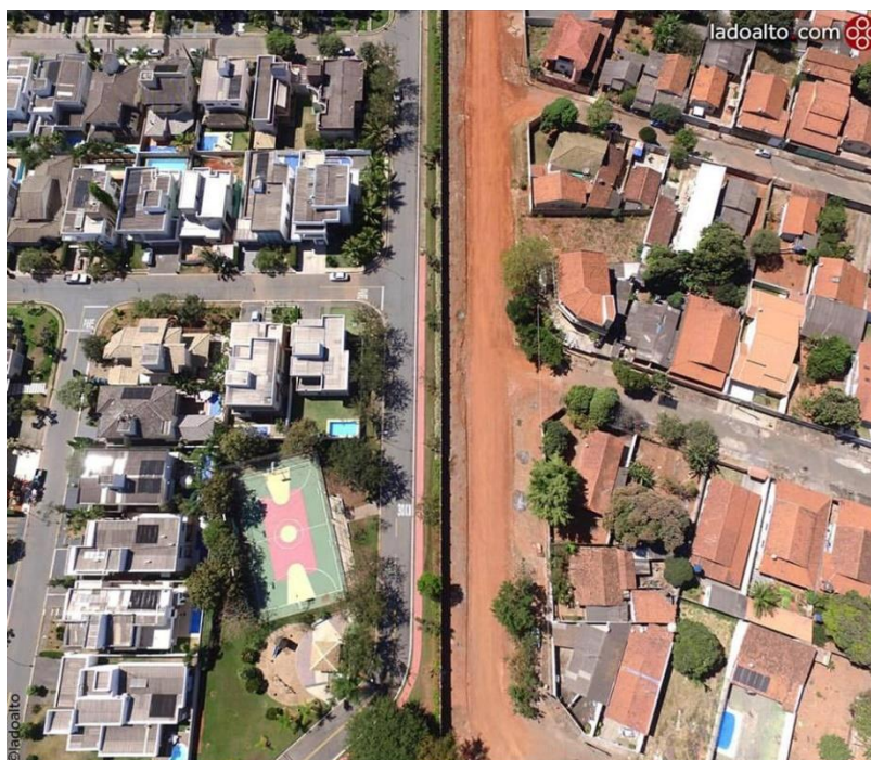
Figura 7 – Vista aérea da divisa entre Jardins Atenas e Jardim Mariliza. Fonte: Lá do Alto (2015).
