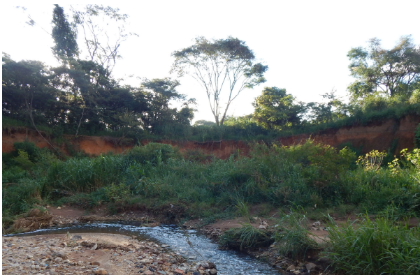
Figura 90 - Erosão das margens. Bacia do córrego Almeida.
