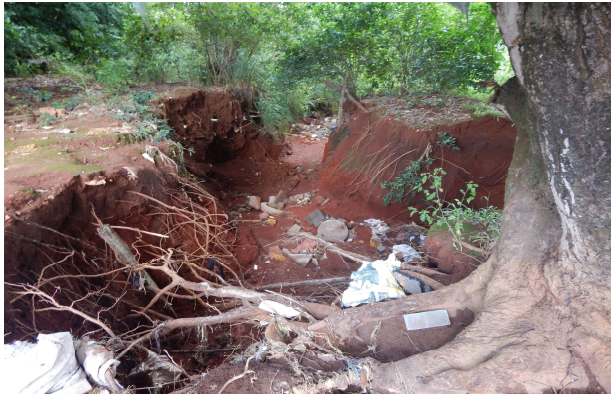
Figura 84 - Erosão. Bacia do córrego Almeida. Fonte: Fotografia de Belizario, W. (2015)
