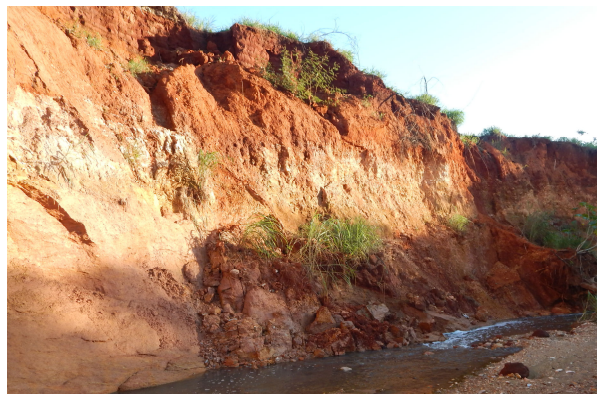
Figura 91 - Erosão das margens. Bacia do córrego Almeida.
