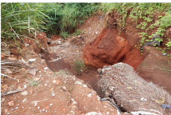
Figura 92 - Erosão na nascente. Bacia do córrego Almeida.
