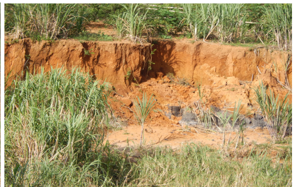
Figura 87 - Erosão na margem. Bacia córrego Almeida. Fonte: Fotografia de Belizario, W. (2015)
