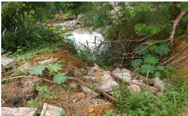
Figura 86 - Erosão na margem. Bacia córrego Almeida. Fonte: Fotografia de Belizario, W. (2015)
