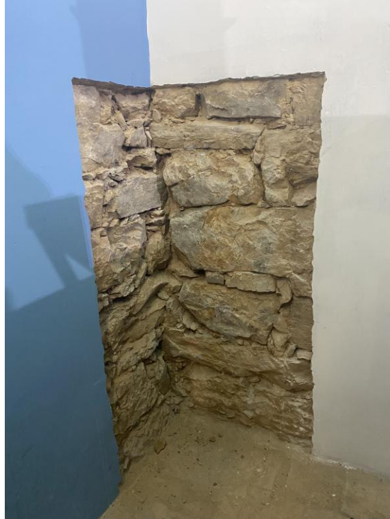
Figura 76 - Interior Igreja Nossa Senhora do Carmo. Piracuruca- PI, 2022
