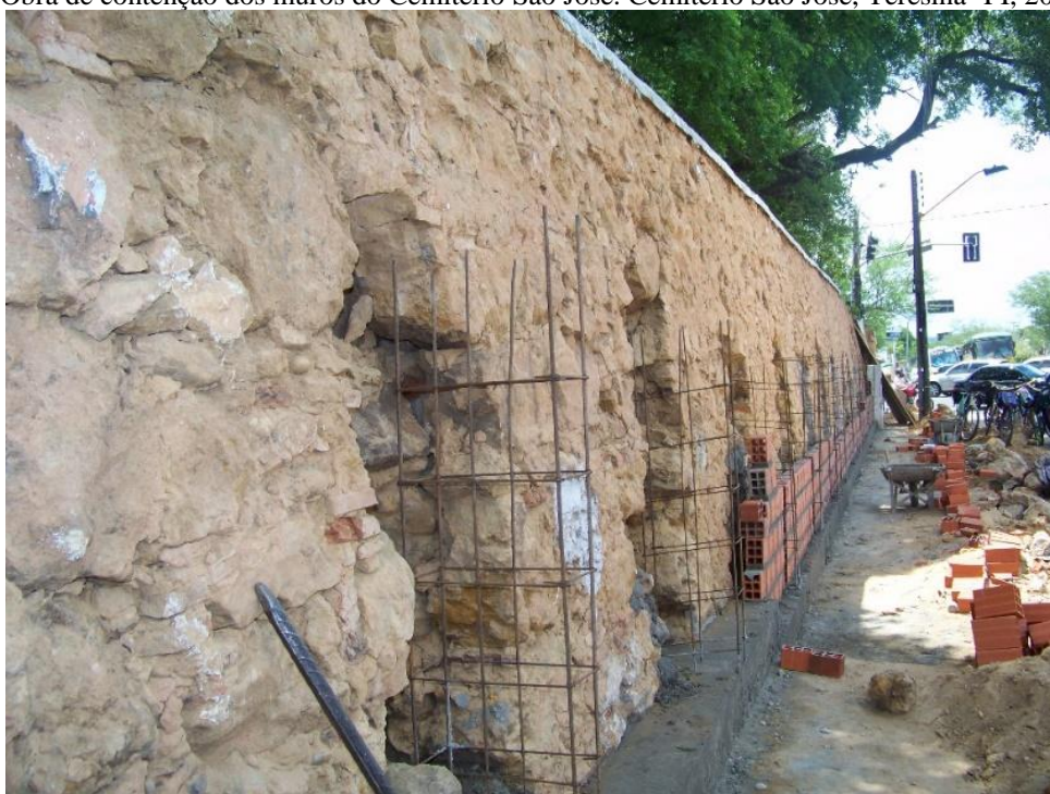
Figura 4 - Obra de contenção dos muros do Cemitério São José. Cemitério São José, Teresina- PI, 2012
