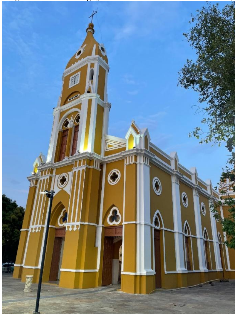
Figura 97 - Fachada da Igreja de São Pedro de Alcântara. Floriano-PI, 2024
