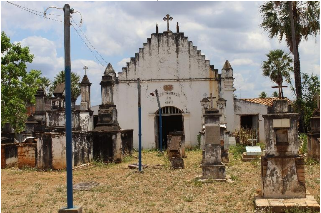
Figura 112 – Capela do Cemitério do Santíssimo Sacramento. Cemitério do Santíssimo Sacramento, Oeiras - PI, 2020
