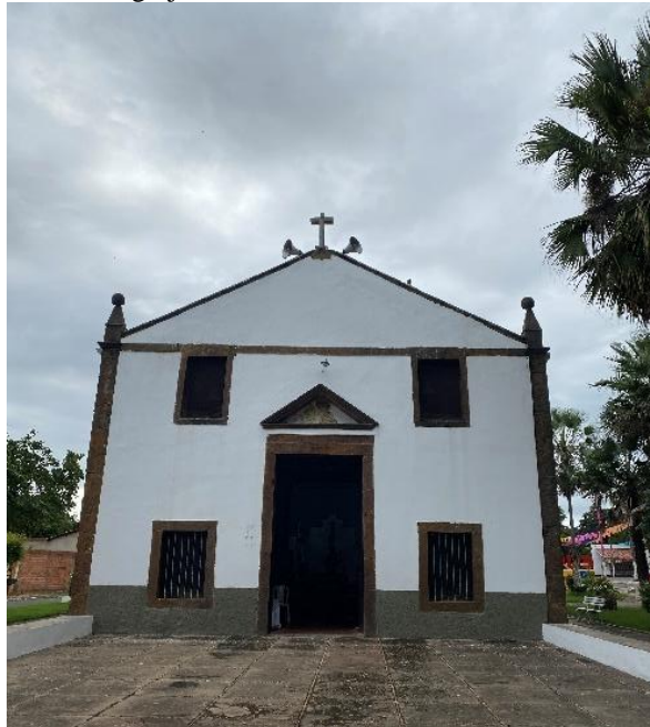
Figura 41 - Fachada da Igreja Matriz de Santo Antônio. Jerumenha, 2023.
