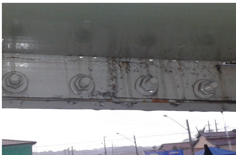
Figura 5.8 - Gotas de água na rampa de acesso da passarela 3 Fonte: Autor
