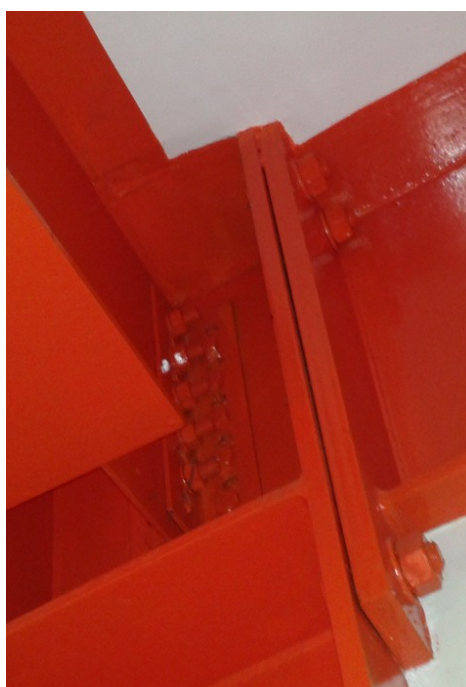
Figura 4.21 - Viga do pavimento tipo do bloco S. ver item 4.16.1.3.2
