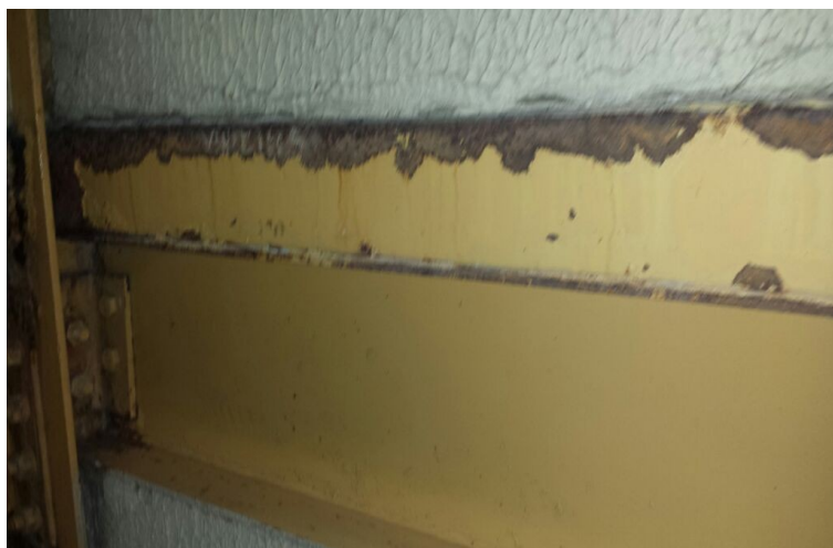
Figura 5.5 - Escada interna do bloco G Fonte: Autor
