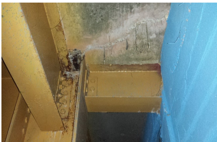
Figura 5.4 - Subsolo do bloco G Fonte: Autor
