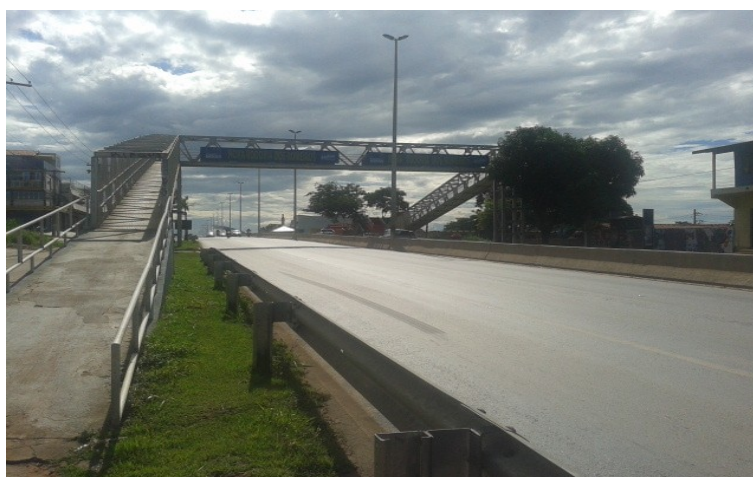
Figura 4.30 - Passarela 2 Fonte: Autor
