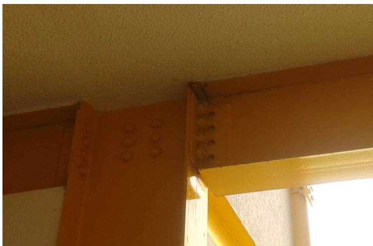
Figura 4.17 - Viga do pavimento tipo do bloco A. Ver item 2.16.1.3.2 Fonte: Autor
