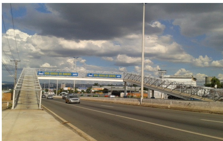
Figura 4.26 - Passarela 1 Fonte: Autor
