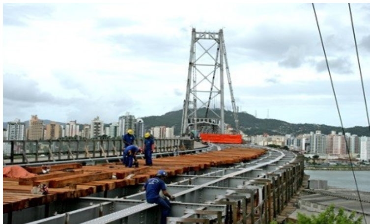
Figura 1.12 - Reforma da ponte Hercílio Luz Fonte: (ASSOCIAÇÃO BRASILEIRA DE IMPRENSA, 2015).
