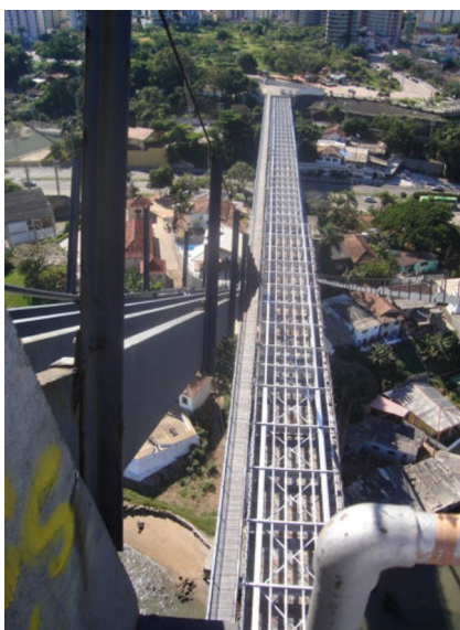
Figura 1.9 – Panorâmica da ponte Hercílio Luz
