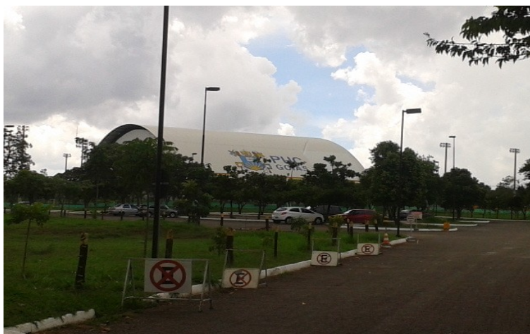
Figura 4.22 - Quadra Poliesportiva Fonte: Autor
