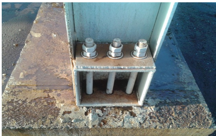
Figura 4.35 - Pilar da Passarela 3. Ver item 2.5.1.4 e 2.5.1.11 Fonte: Autor
