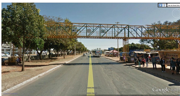
Figura 4.1 - Vista lateral Fonte: Google
