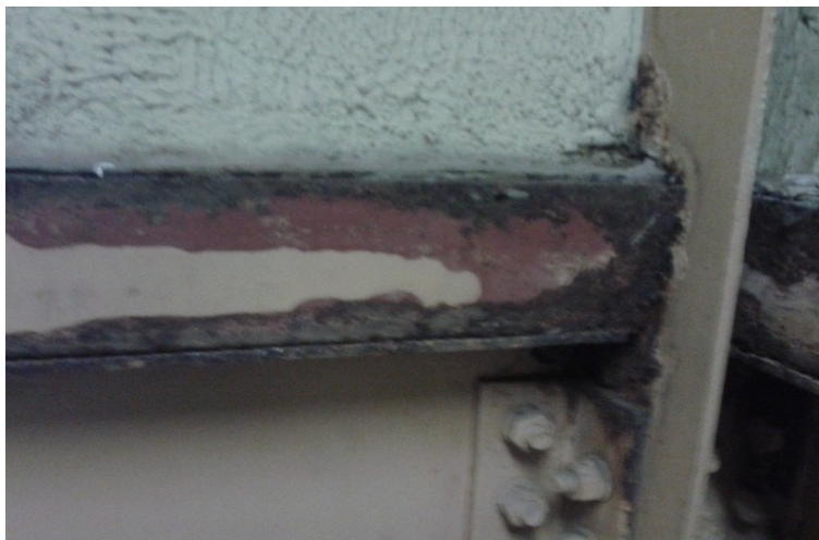
Figura 4.10 - Viga da caixa da escada interna do bloco F. Ver item 2.5.1.4 Fonte: Autor
