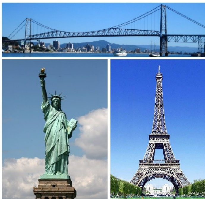
Figura 1.1 - Monumentos com estruturas metálicas Fonte: Ponte Hercílio Luz (THINA, 2009), Estátua da Liberdade (SCHMTT, 2013) e Torre Eiffel (TIRLONI, 2012)
