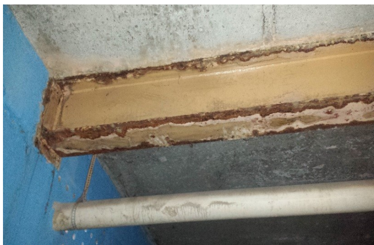
Figura 4.9 - Viga do subsolo do bloco F. Ver item 2.5.1.4 Fonte: Autor
