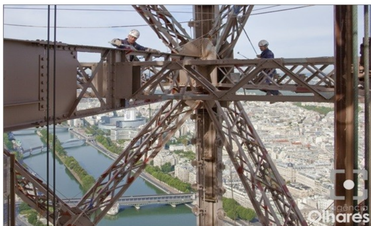
Figura 1.5 - Reforma na Torre Eiffel
