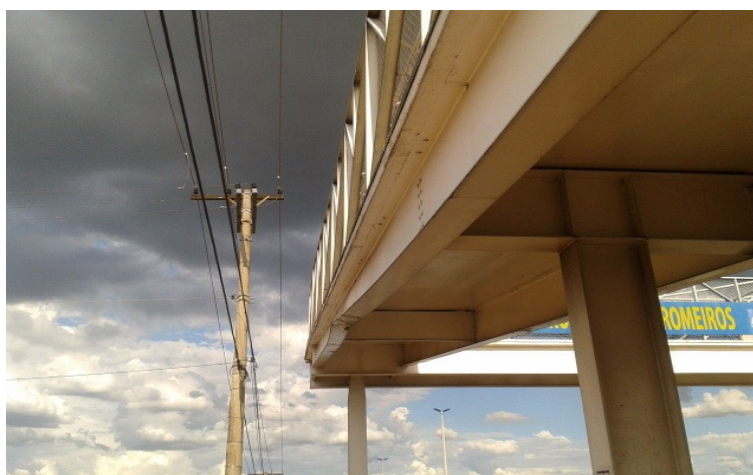
Figura 4.27 - Viga da Passarela 1. Ver item 2.5.1.11 Fonte: Autor
