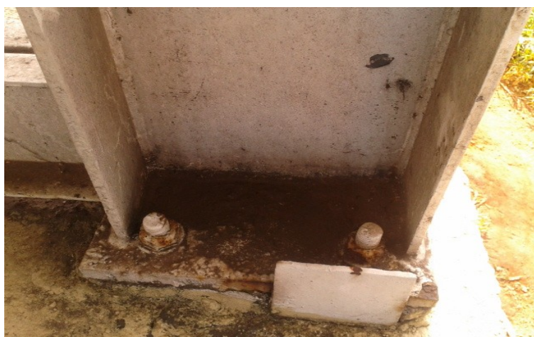
Figura 4.31 - Pilar da Passarela 2. Ver item 2.5.1.4 e 2.5.1.11 Fonte: Autor
