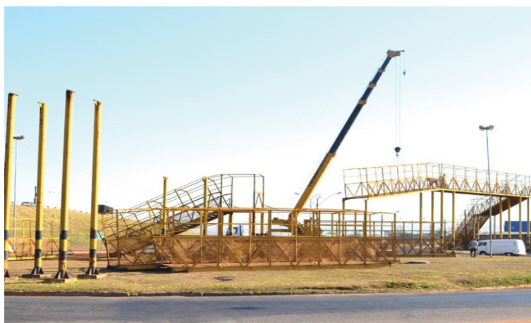
Figura 1.19 - Retirada da passarela
