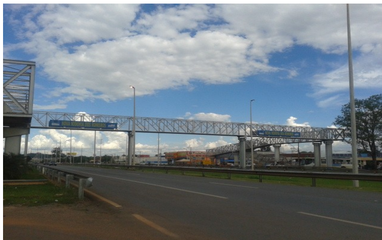
Figura 4.38 - Passarela 4 Fonte: Autor
