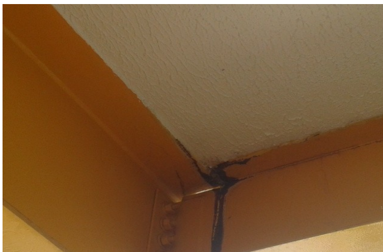
Figura 4.15 - Viga do bloco A Ver item 2.3.1.4 Fonte: Autor
