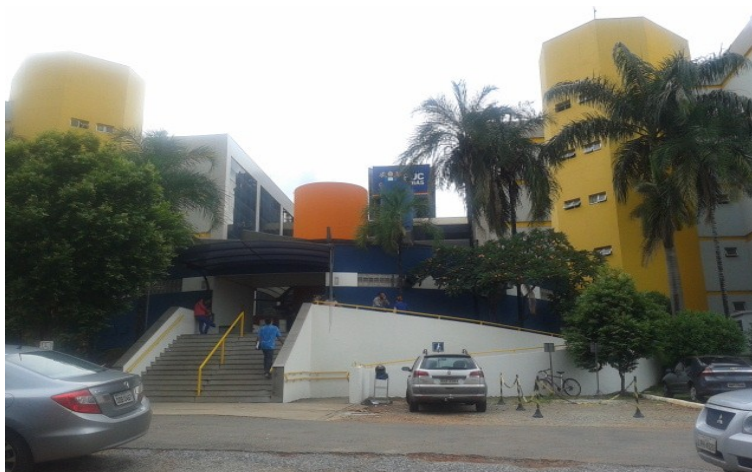
Figura 4.14 - Entrada do bloco A e B Fonte: Autor
