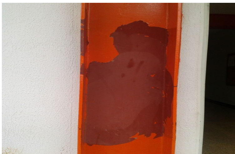
Figura 4.19 - Pilar do bloco S. Ver Item Fonte: Autor
