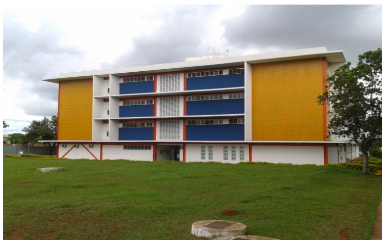
Figura 4.18 - Entrada do bloco S Fonte: Autor
