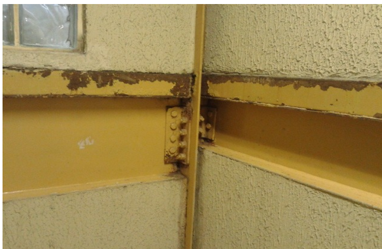
Figura 5.3 - escada interna do bloco F Fonte: Autor
