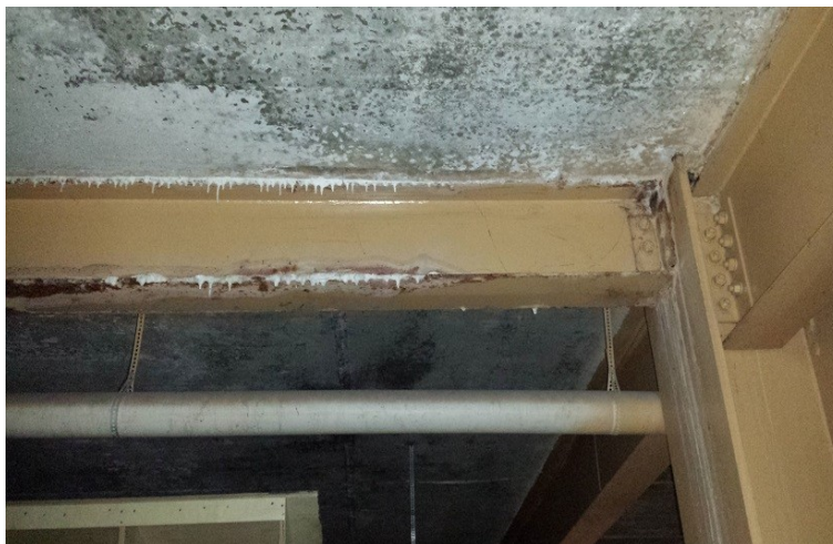
Figura 5.2 - Subsolo do bloco F Fonte: Autor
