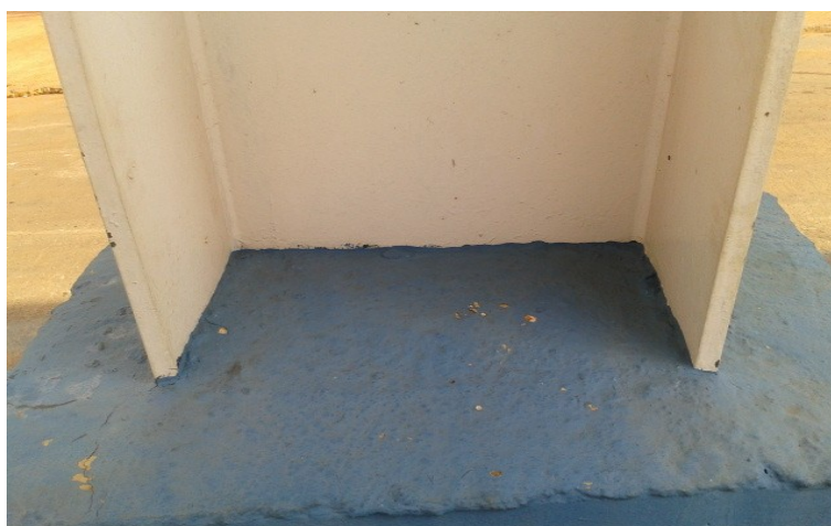
Figura 4.34 - Passarela 3 Fonte: Autor
