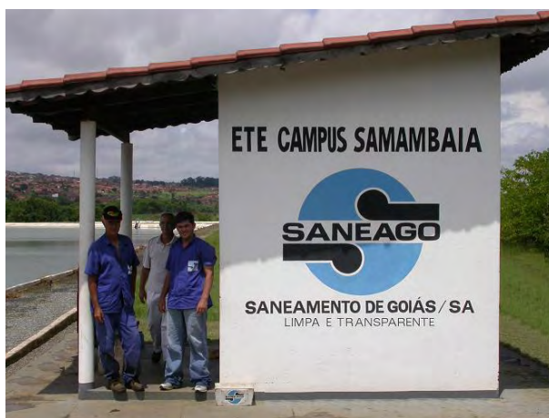
Figura 15 Vista parcial da Estação de Tratamento de Esgotos - ETE Samambaia, local de realização do experimento.
