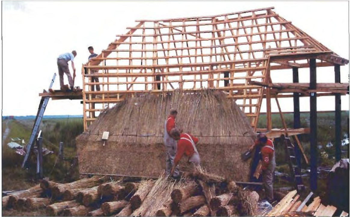
Figura 14 Caniço sendo utilizado para cobertura de um telhado no norte de Limfjord (Dinamarca) (BRIX, 1994c).
