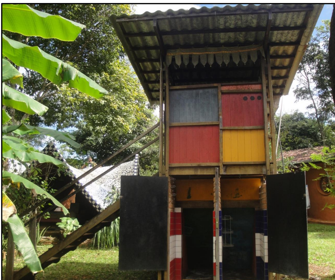
Figura 67 – Banheiro seco no IPEC
