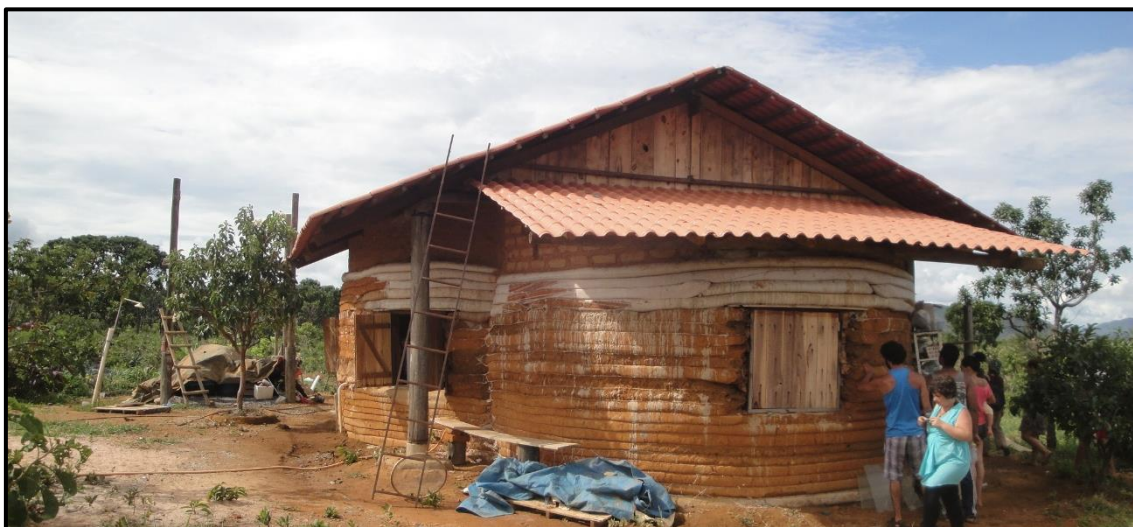
Figura 66 - Casa construída com diferentes técnicas de bioconstrução no IBC - 2
