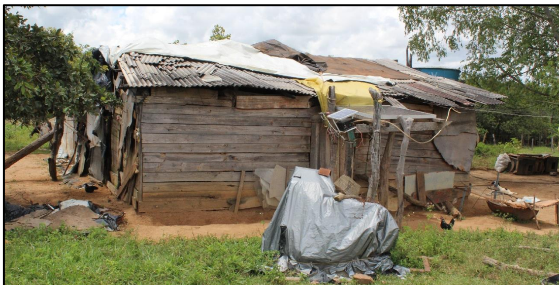
Figura 30 – Habitação em assentamento atingido por empreendimento de geração de energia
