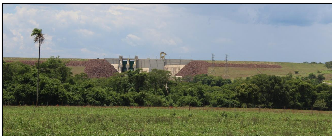
Figura 42 – Registro fotográfico de barragem realizado a partir da porteira de uma propriedade localizada a jusante a menos de um quilômetro de distância
