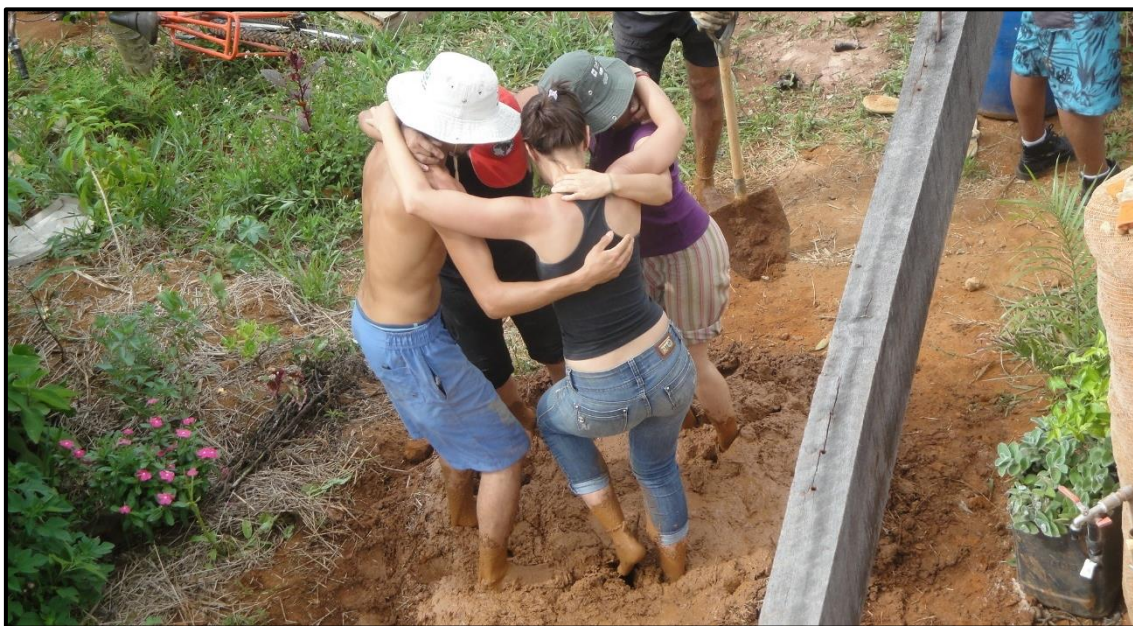
Figura 70 – Oficina de reboco no IBC
