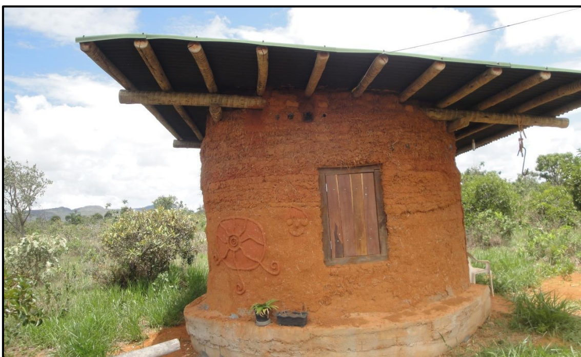
Figura 65 - Estrutura construída com diferentes técnicas de bioconstrução no IBC
