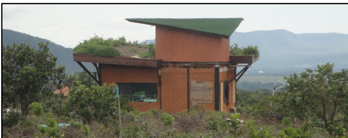
Figura 64 – Casa construída com diferentes técnicas de bioconstrução no IBC - 1
