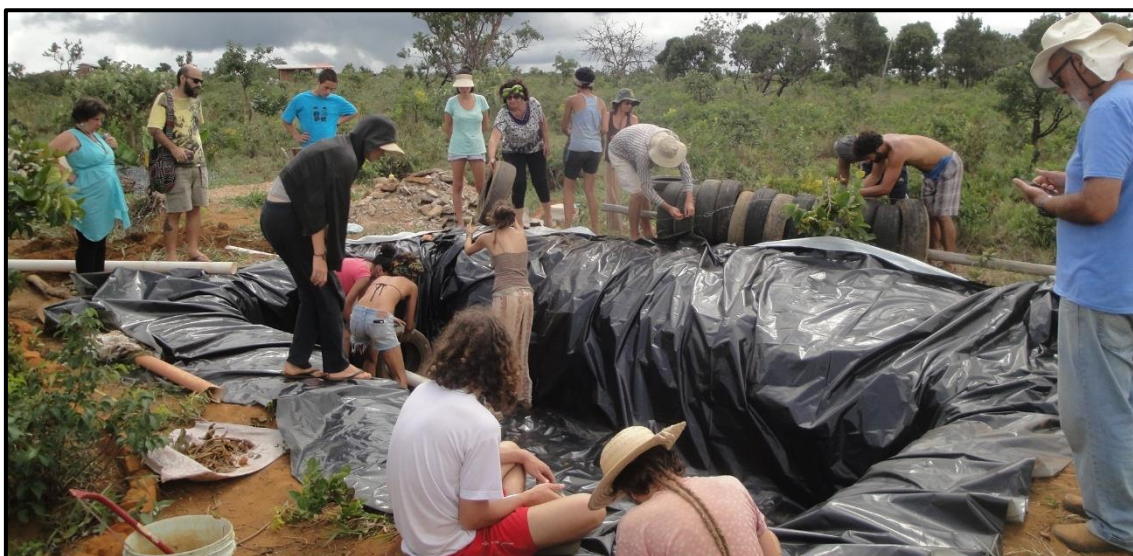
Figura 69 – Mutirão de construção de uma bacia de evapotranspiração no IBC
