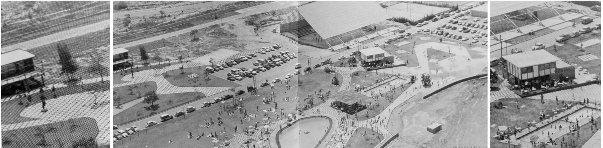
Figura 96: Ao centro, imagem aérea do late Clube de Brasília em 1962. As fotografias à direita e à esquerda são um recorte e ampliação da fotografia do meio e mostram a Segunda Sede Social do late Clube de Brasília e o Pavilhão Provisório já sem a escada externa. Fonte: Finger (2020, p. 46-47). Montagem: elaborado pelo autor (2023).
