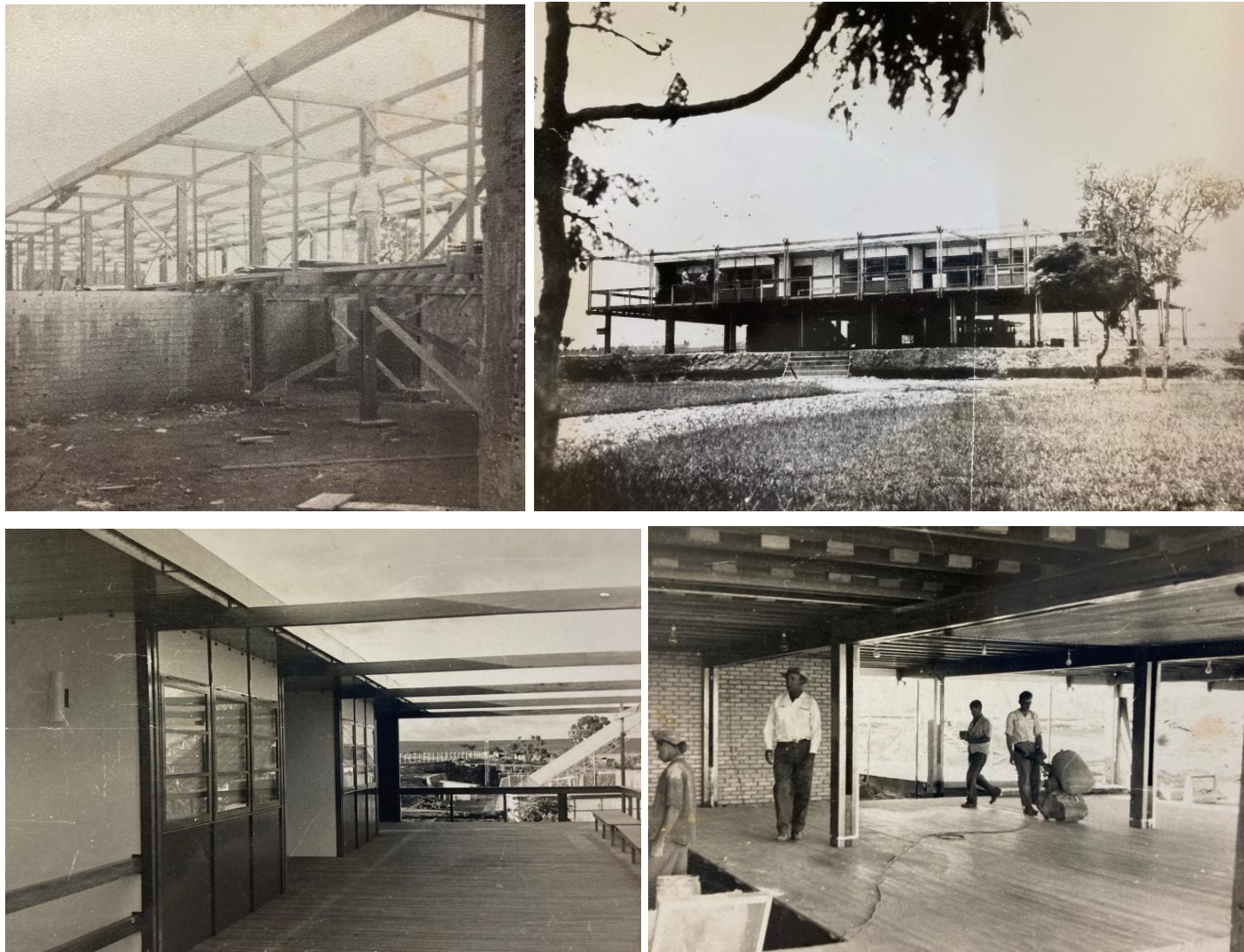
Figura 111: Segunda Sede do ICB sendo construída, com ênfase na "gaiola" e nas paredes em alvenaria do térreo. A fachada principal do edifício, sua varanda no pavimento superior e o deck de madeira do pavimento térreo sendo lixado com maquinário elétrico manuseado por um executor. Fonte: late... (1962, s.p.). Digitalizado pelo autor (2023).
