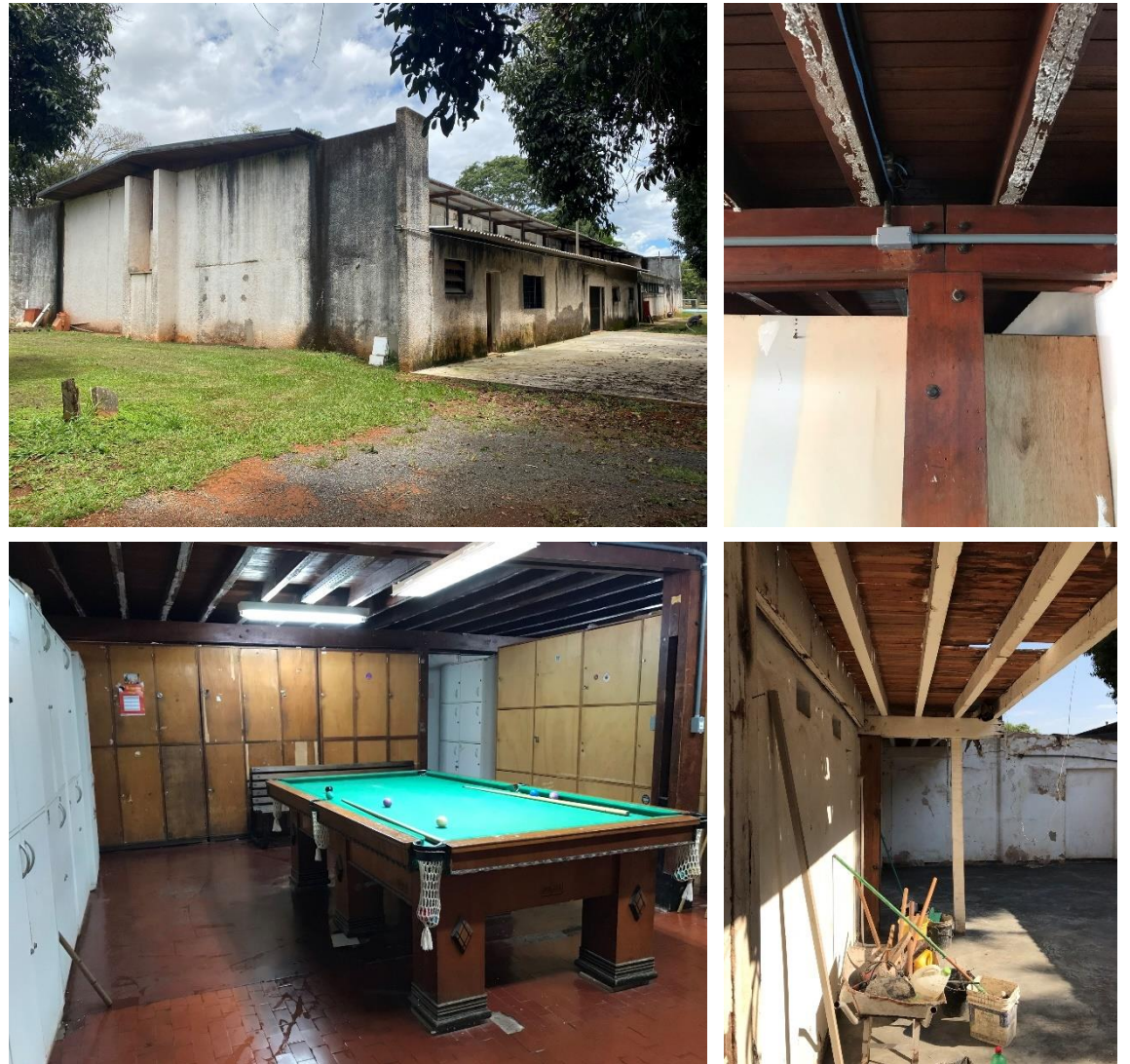
Figura 90: Anexo construído na fachada posterior. Conexão das vigas nos pilares centrais. Sala de descanso dos funcionários. Varanda da fachada posterior. Fonte: elaborado pelo autor (2023).
