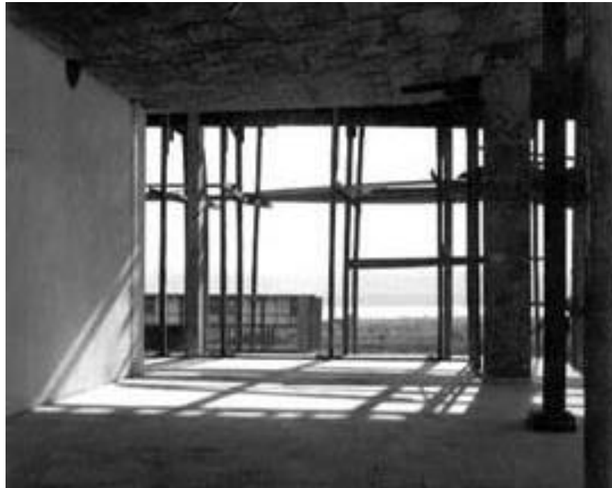
Figura 94: Sede da Faculdade de Educação sendo construída. A fotografia mostra o processo de execução do edifício com escoras de obra, paredes e lajes incipientes em primeiro plano. Ao fundo, quase despercebido, figura o pavilhão do OCA II. Fonte: AtoM UnB (1962a, s.p.).
