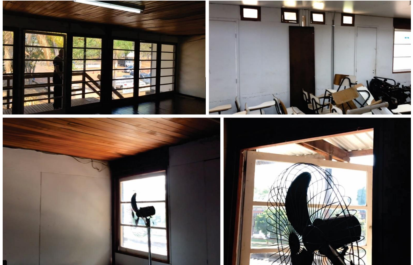
Figura 92: Algumas das portas e janelas vistas internamente ao OCA II com ênfase nas portas da antiga sala de estar, os basculantes dos banheiros e quartos e as janelas com sistema de abertura de giro que iluminavam os quartos. Fonte: elaborado pelo autor (2023).
