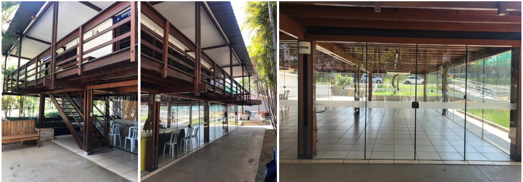
Figura 120: À esquerda, a escada externa com a floreira alta atrás do banco de madeira. Ao centro, a fachada principal com a cobertura, os fechamentos em vidro do térreo e os esteios que conectam as vigas. À direita, os planos de vidro que fecham o pavimento térreo e tentam alcançar alguma permeabilidade visual. Fonte: elaborado pelo autor (2023).
