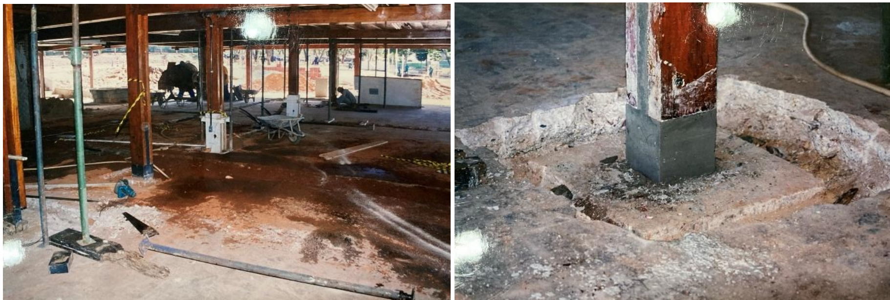
Figura 117: À esquerda, o processo de substituição dos arranques de madeira por peças de concreto e um detalhe que mostra o bloco da fundação com a base dos pilares agora em concreto. Fonte: Obras... (1998, s.p.). Montagem: elaborado pelo autor (2023).
