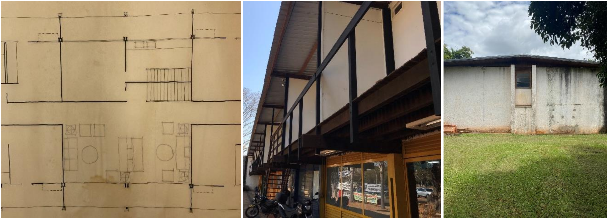
Figura 85: À esquerda, desenho de Rodrigues estudando o arranjo do mobiliário e os painéis que protegem e particularizam as varandas no Bloco 2. Ao centro, fotografia que mostra os painéis desenhados pelo arquiteto na varanda do Bloco 2. À direita, uma das empenas laterais em alvenaria com a janela recuada em B2. Fonte: B2... (s.d., s.p.); Fotografia e Montagem: elaborado pelo autor (2023).
