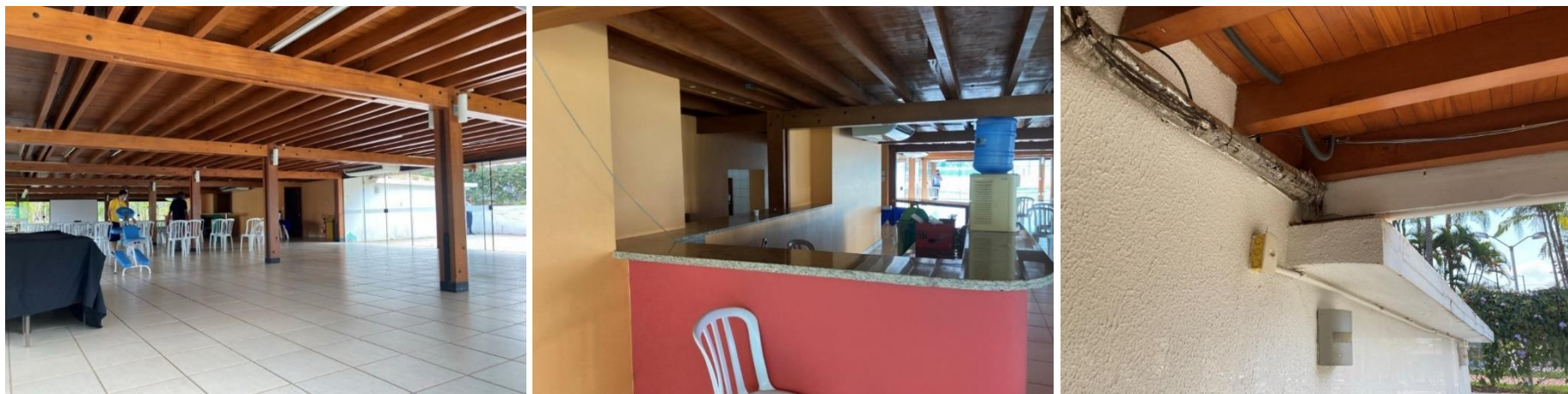
Figura 119: À esquerda, salão de eventos no pavimento térreo com mobiliário de plástico solto. Ao centro, balcão fixo com acesso direto para a cozinha. À direita, laje impermeabilizada do anexo em alvenaria abaixo da placa de vedação do volume suspenso. Fonte: elaborado pelo autor (2023).
