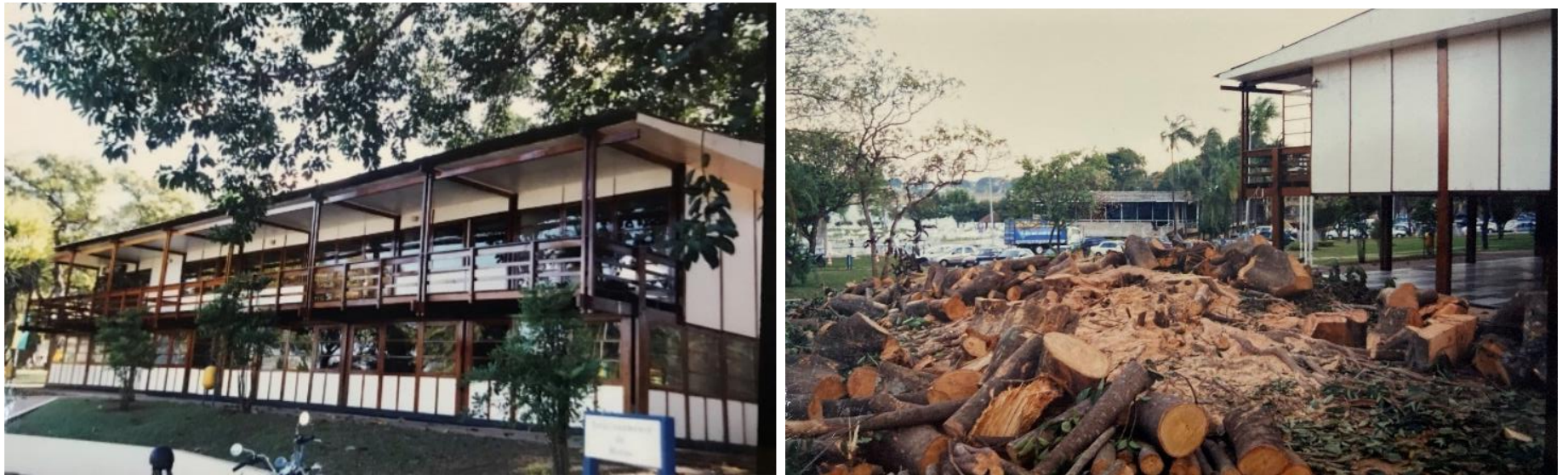
Figura 118: À esquerda, o edifício do ICB logo antes da reforma de 2002. À direita, árvore que foi retirada cuja copa recobria parte da cobertura do pavilhão. Fonte: Obras... (1998, s.p.). Montagem: elaborado pelo autor (2023).
