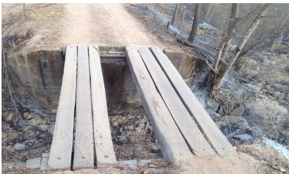
Figura 9 - Ponte na estrada de acesso à comunidade Riachão. Fonte: Acervo próprio (2015)
