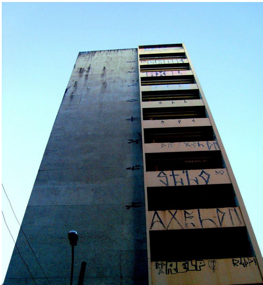
Figura 17. Prédio abandonado, localizado na Avenida Goiás. Fonte: Acervo pessoal (2014).
