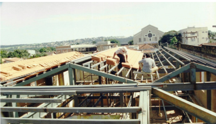
Imagem 31: Colocação de novas telhas sobre caibros, terças e tesouras metálicas. Fonte: Arquivo Biblioteca Cora Coralina.
