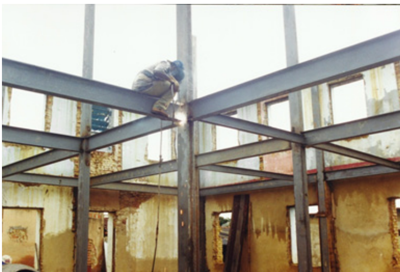
Imagem 26: A estrutura metálica foi utilizada como malha estrutural que sustentou todo o edifício. Fonte: Arquivo Biblioteca Cora Coralina.
