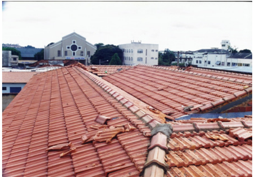
Imagem 32: Vista da cobertura. Fonte: Arquivo Biblioteca Cora Coralina.
