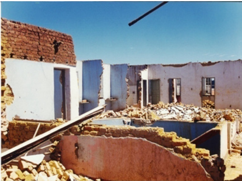
Imagem 25: Demolição das paredes do pavimento superior do Palace Hotel, 1999. Fonte: Arquivo Biblioteca Cora Coralina.
