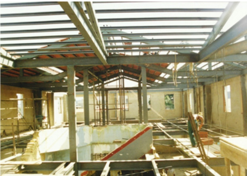
Imagem 30: A estrutura metálica também utilizada na cobertura. Fonte: Arquivo Biblioteca Cora Coralina.
