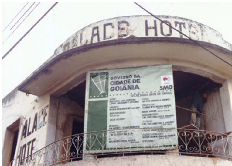
Imagem 23: Sacada do Palace Hotel com a placa da obra da Reforma, 1999. Fonte: Arquivo Biblioteca Cora Coralina.
