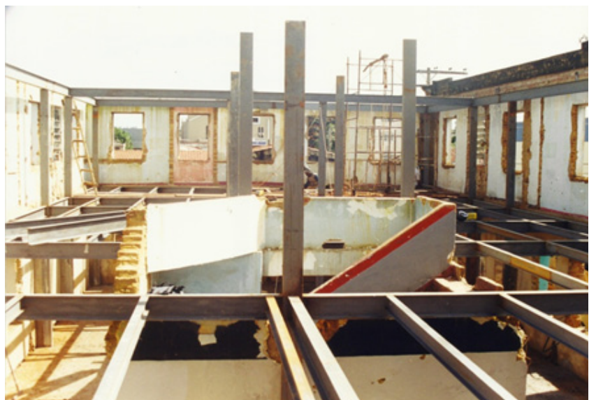
Imagem 28: A estrutura metálica incorporada à caixa da escada em alvenaria estrutural. Fonte: Arquivo Biblioteca Cora Coralina.
