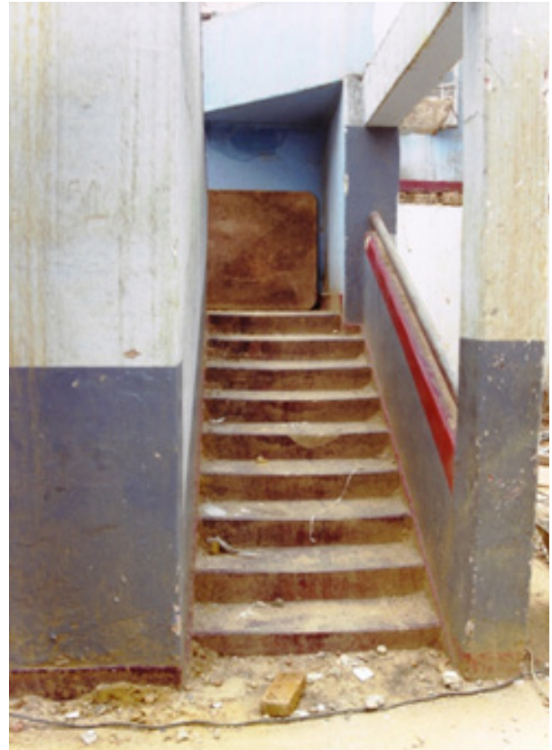
Imagem 27: A caixa de alvenaria autoportante em volta da escada central foi preservada e utilizada como elemento que apoiou a malha estrutural em estrutura metálica, 11 de fevereiro de 1999. Fonte: Arquivo Biblioteca Cora Coralina.
