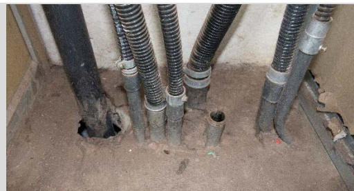
Figura 4.3-15 Tubulação concretada na laje Fonte: Acervo fotográfico do autor
