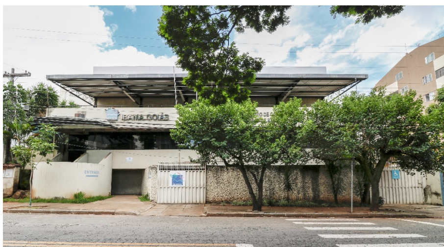
Figura 4.2-4 Fachada Atual do IBAMA Fonte: Acervo do autor
