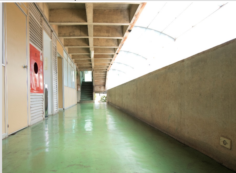
Figura 4.3-11 Caixa de passagem em viga guarda corpo Fonte: Acervo fotográfico do autor
