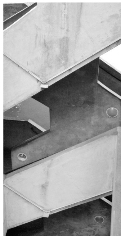
Figura 4.2-15 Guarda-corpo, Fotografia In loco Fonte: Acervo do autor
