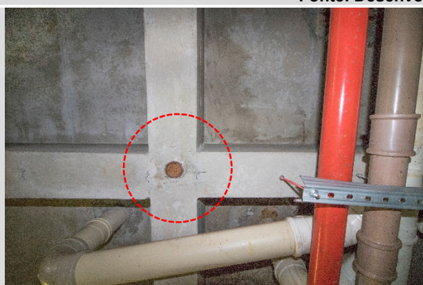
Figura 4.3-24 Execução com furo na nervura para passagem de tubulação Fonte: Acervo fotográfico do autor
