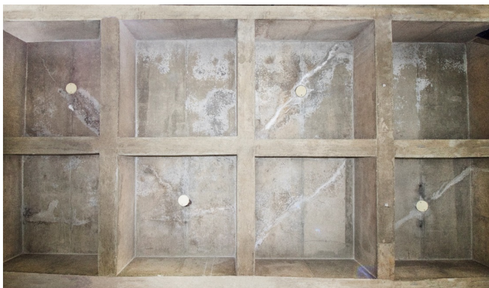
Figura 4.2-26 Ponto de iluminação intercalados na laje, "Tabuleiro de Xadrez". Fonte: Acervo fotográfico do Autor
