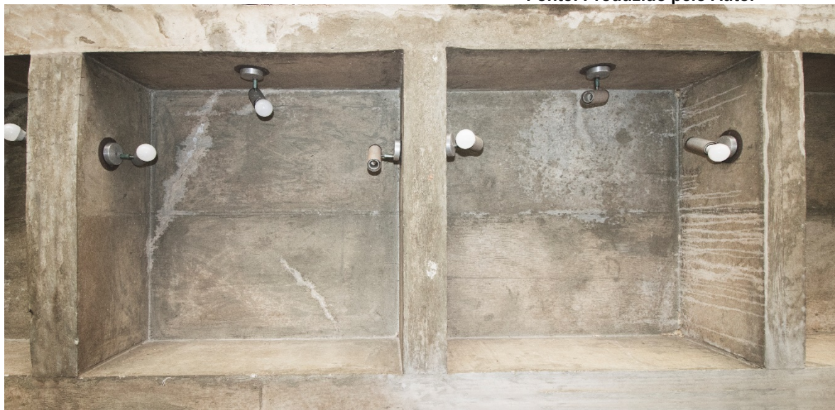
Figura 4.2-30 Marcação dos dois meios caixotes, formas, entre as nervuras Fonte: Acervo fotográfico do Autor
