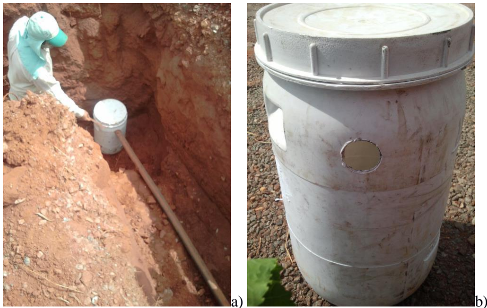
Figura 12 (a) Instalação do dreno de coleta de lixiviado da trincheira experimental à bombona utilizada para armazenamento do líquido; (b) Detalhe da bombona utilizada.
