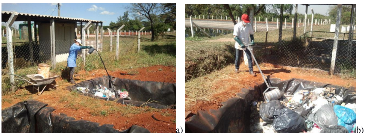
Figura 10 (a) Lançamento do lodo de fossa sobre os resíduos (b) Compactação manual dos resíduos dispostos na trincheira 1
