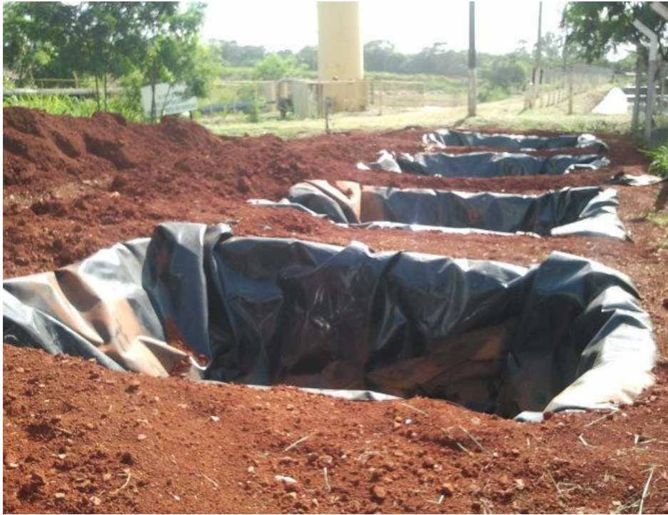
Figura 7 Ancoragem das geomembranas nas trincheiras experimentais
