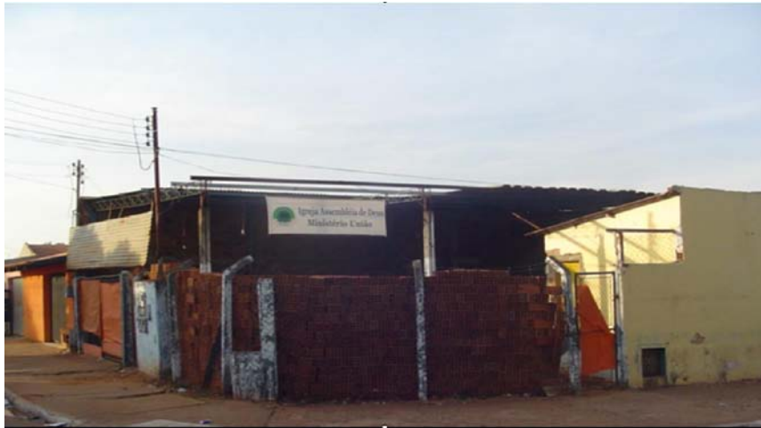
Figura 02 – Construção de uma igreja Assembléia de Deus na Região Noroeste de Goiânia.
