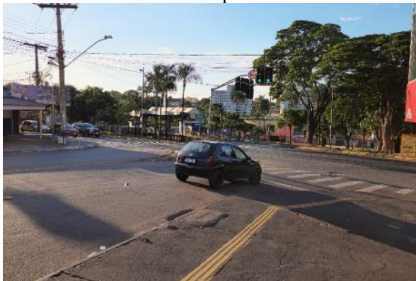
Figura 15: Pç. Palmito: o único cruzamento favorável à travessia de pedestres.
