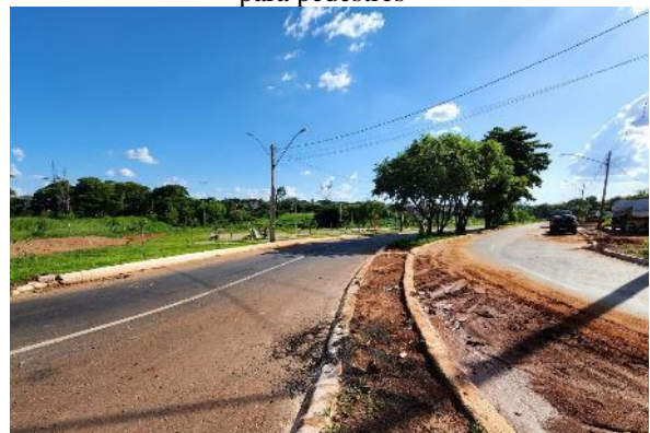
Figura 10: Av. Acary Passos: ausência de sinalização para pedestres
