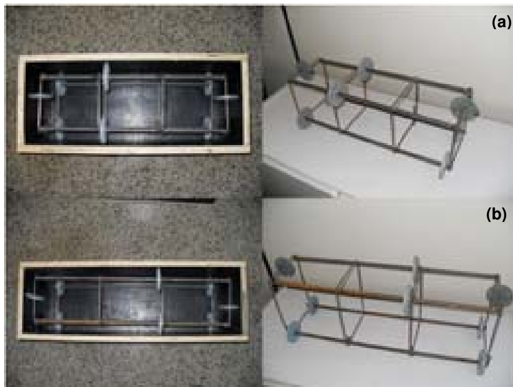
Figura 3.7 – Vista geral das fôrmas de madeira e das armaduras para moldagem do protótipos prismáticos de viga de concreto. (a) armação referente ao protótipo de dimensões 20 cm x 20 cm x 52 cm, (b) armação referente ao protótipo de dimensões 20 cm x 25 cm x 65 cm.
