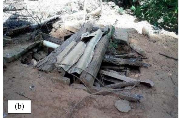
Figura 1-Fossas rudimentares com fechamento precário nas comunidades de Itajá II (a) e Povoado Veríssimo (b).
