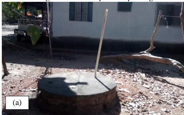
Figura 4-Fossa de pedra Tapiocanga na comunidade de Lagoa do Lago (a) e Capela (b).
