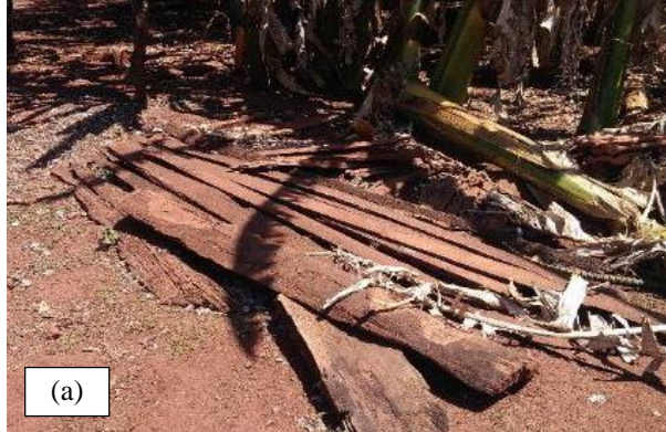
Figura 1-Fossas rudimentares com fechamento precário nas comunidades de Itajá II (a) e Povoado Veríssimo (b).
