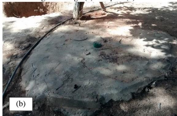
Figura 4-Fossa de pedra Tapiocanga na comunidade de Lagoa do Lago (a) e Capela (b).
