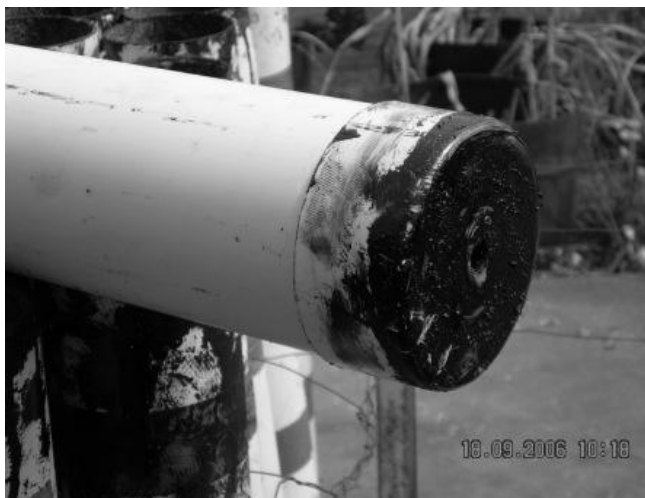
Figura 4. Detalhe do dreno das colunas.
