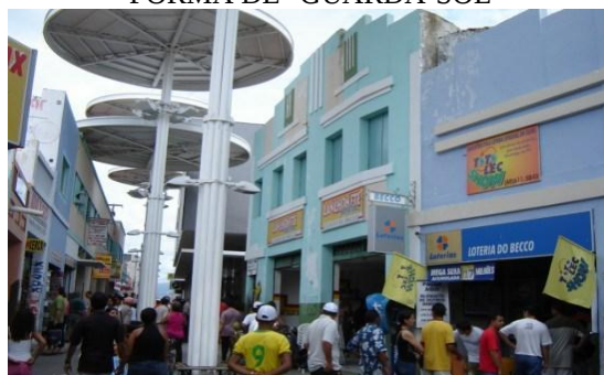
FIGURA 37 - VISTA DE UMA DAS EXTREMIDADES DO BECO DO COTOVELO, COM SUAS ESTRUTURAS SUSPENSAS EM FORMA DE "GUARDA-SOL"
