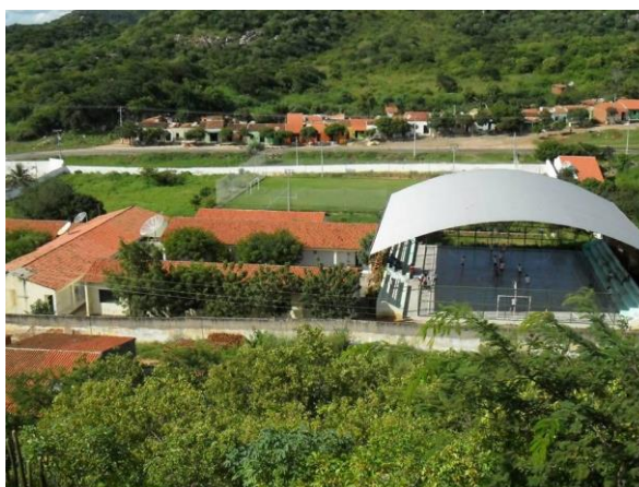
FIGURA 10 - ESCOLA REFORMADA E COM QUADRA COBERTA
