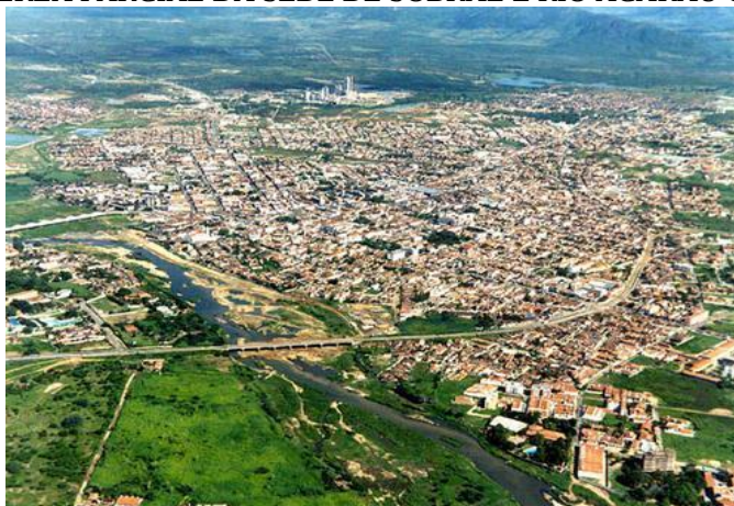
FIGURA 12 - VISTA AÉREA PARCIAL DA SEDE DE SOBRAL E RIO ACARAÚ QUE CORTA A CIDADE
