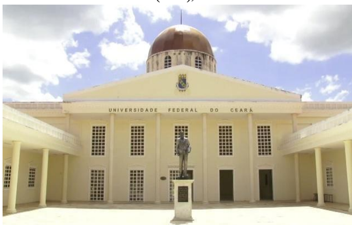
FIGURA 45 - FACHADA DO PRÉDIO DA FACULDADE DE MEDICINA DA UNIVERSIDADE FEDERAL DO CEARÁ (UFC), EM SOBRAL
